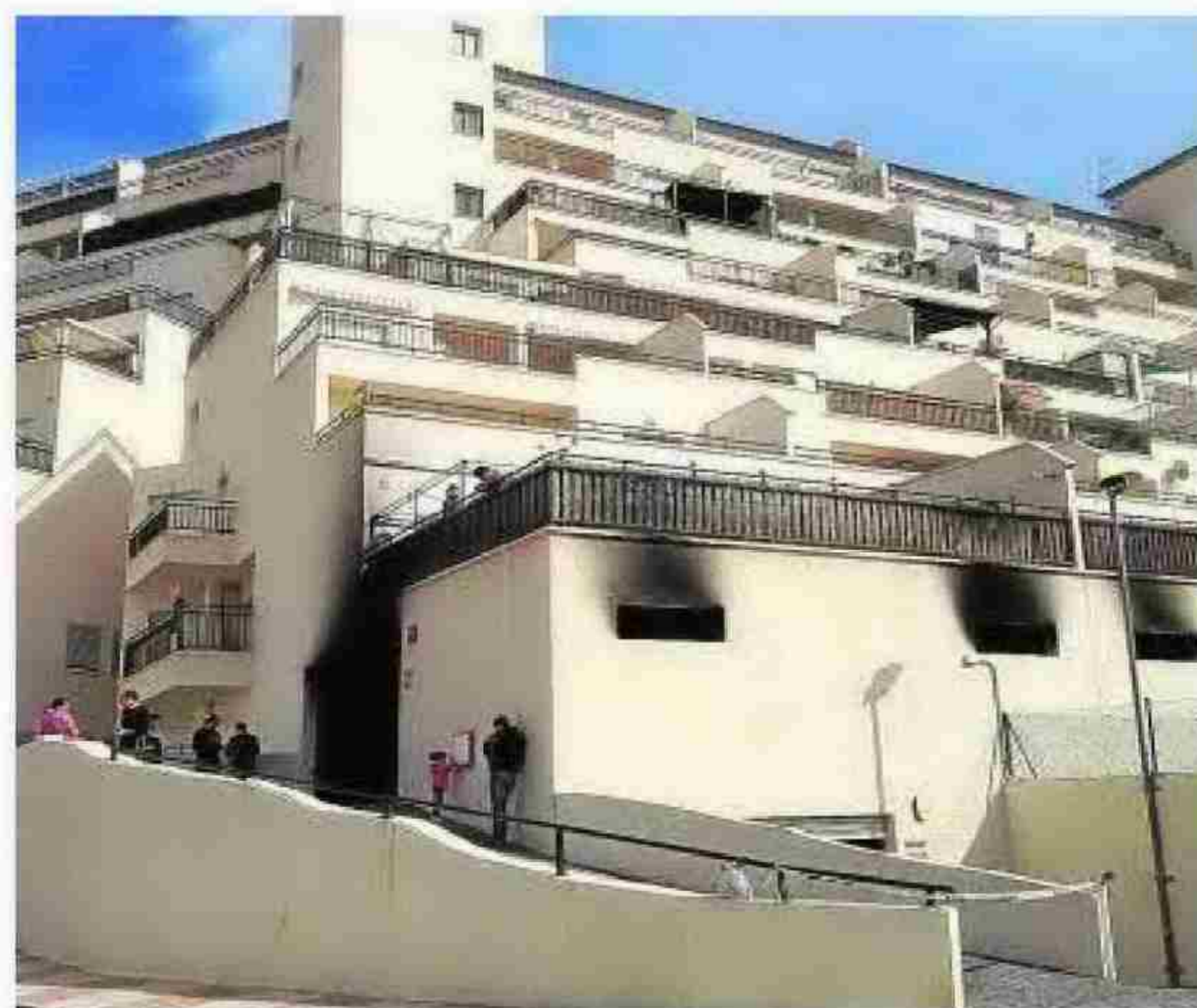
Los garajes muestran las huellas del incendio. :: VALDIVIA
