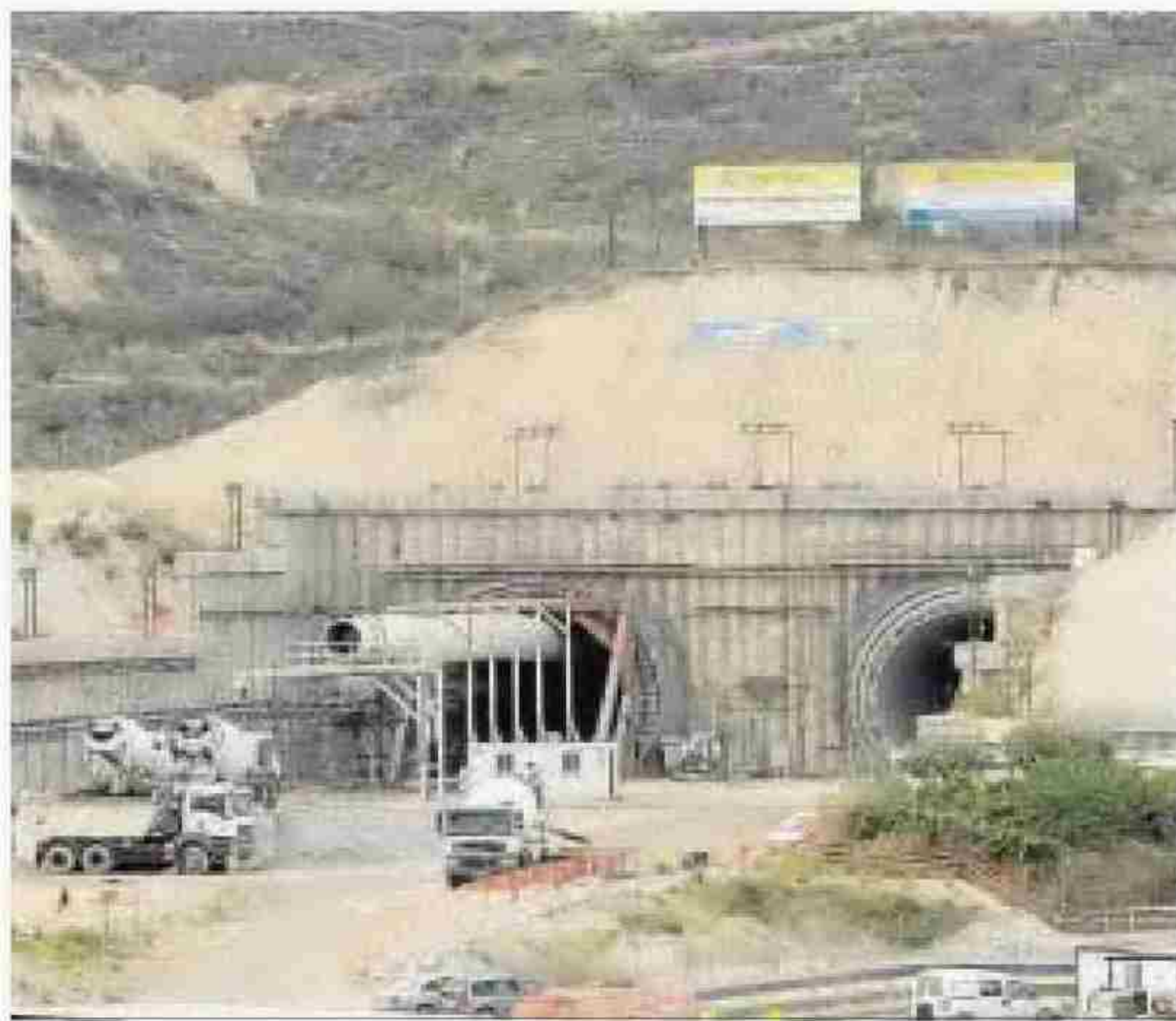
Obras de la línea de Alta Velocidad en la comarca del Levante. JAVIER ALONSO
