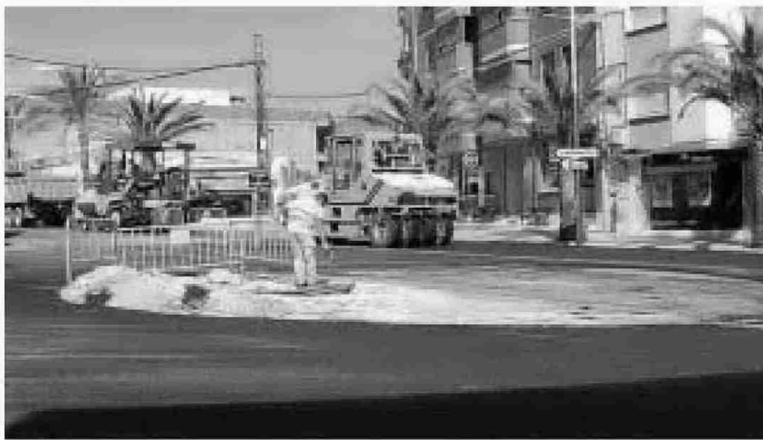
La nueva rotonda en la Avenida Almanzora mejorará el tráfico.
