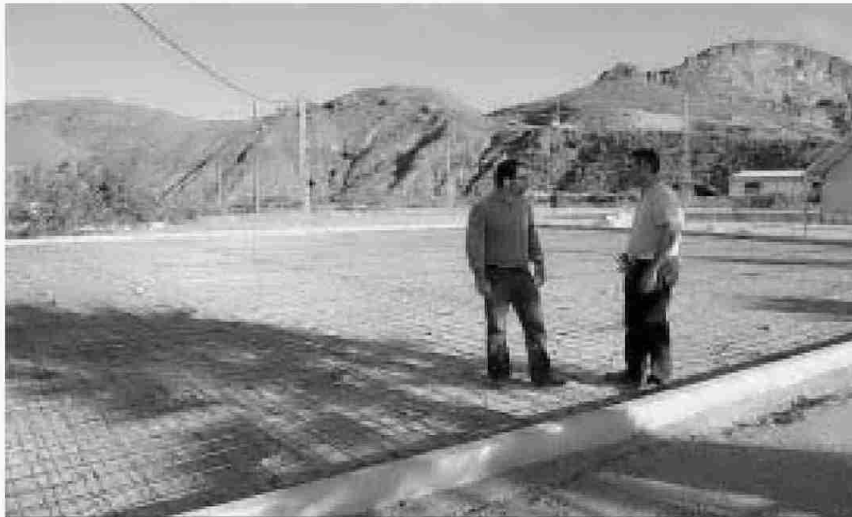
La nueva pista de 'skate' se construye junto al Pabellón Municipal.
