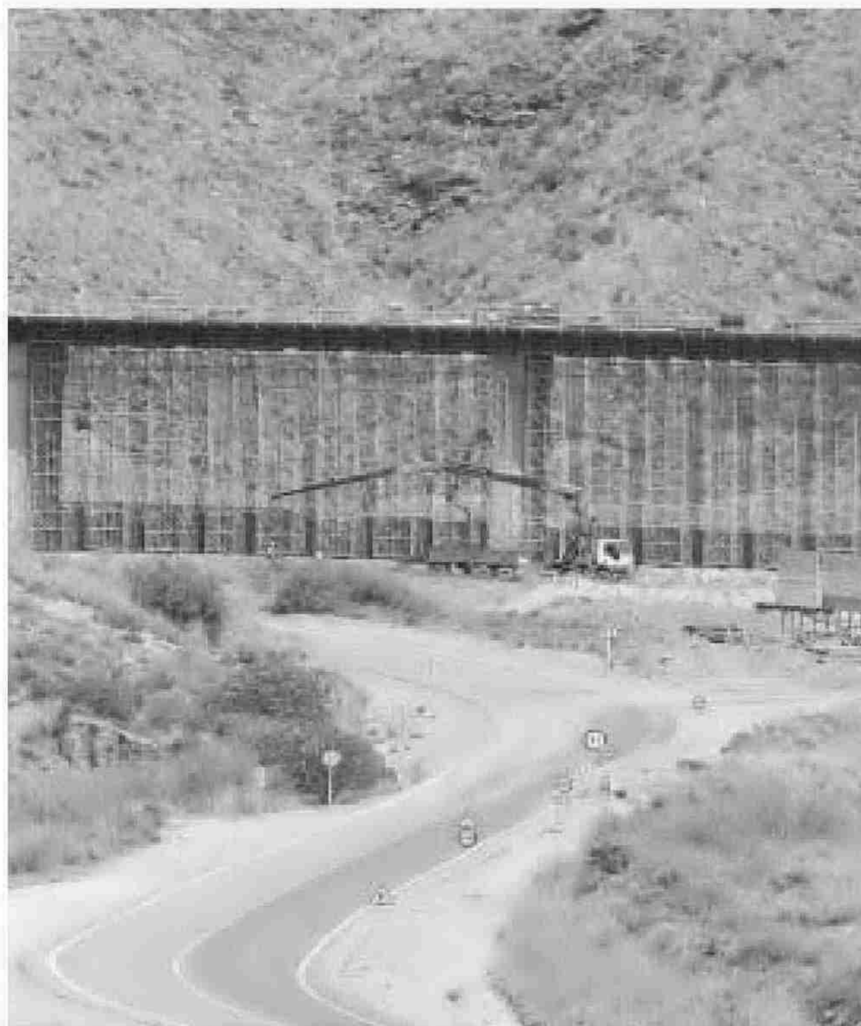
Obras de un tramo del AVE en la provincia de Almería.
