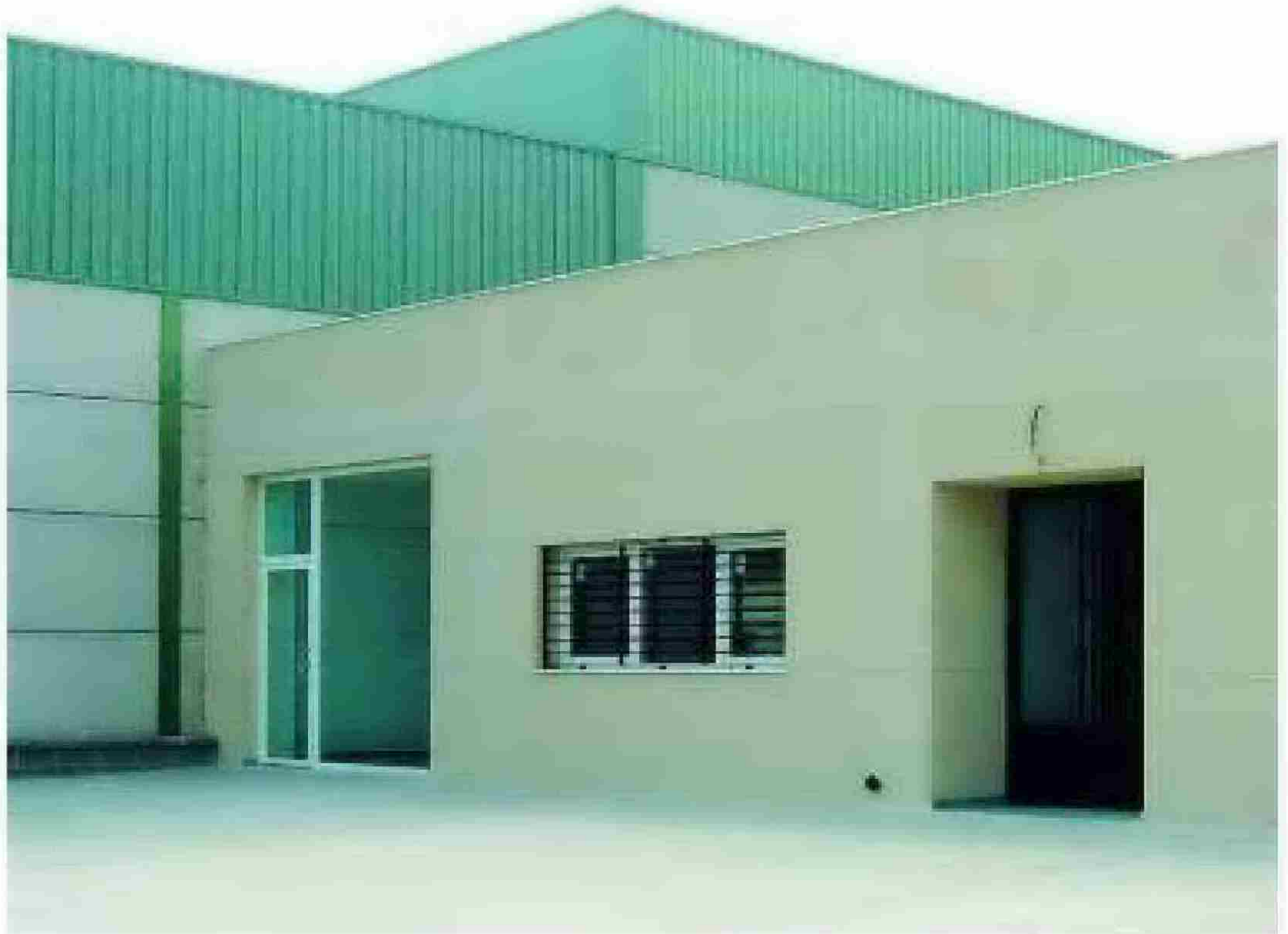
El centro está situado en el nº 27 de la calle Sierra de la Atalaya de Santa María del Águila . :: T.C.G.
