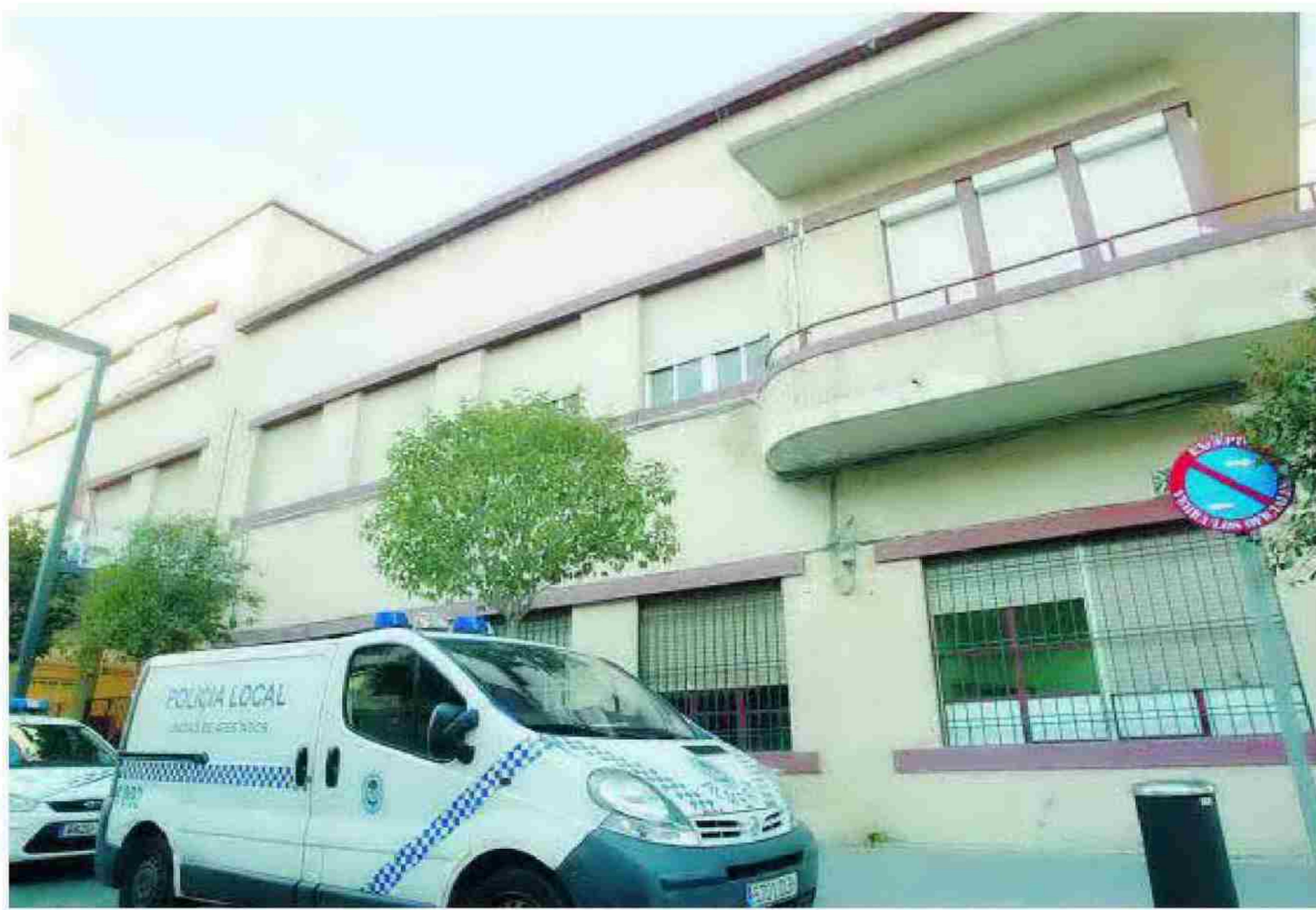
Dependencias del actual Cuartel de la Policía Local, en la calle Santos Zárate. :: M. MANZANO
