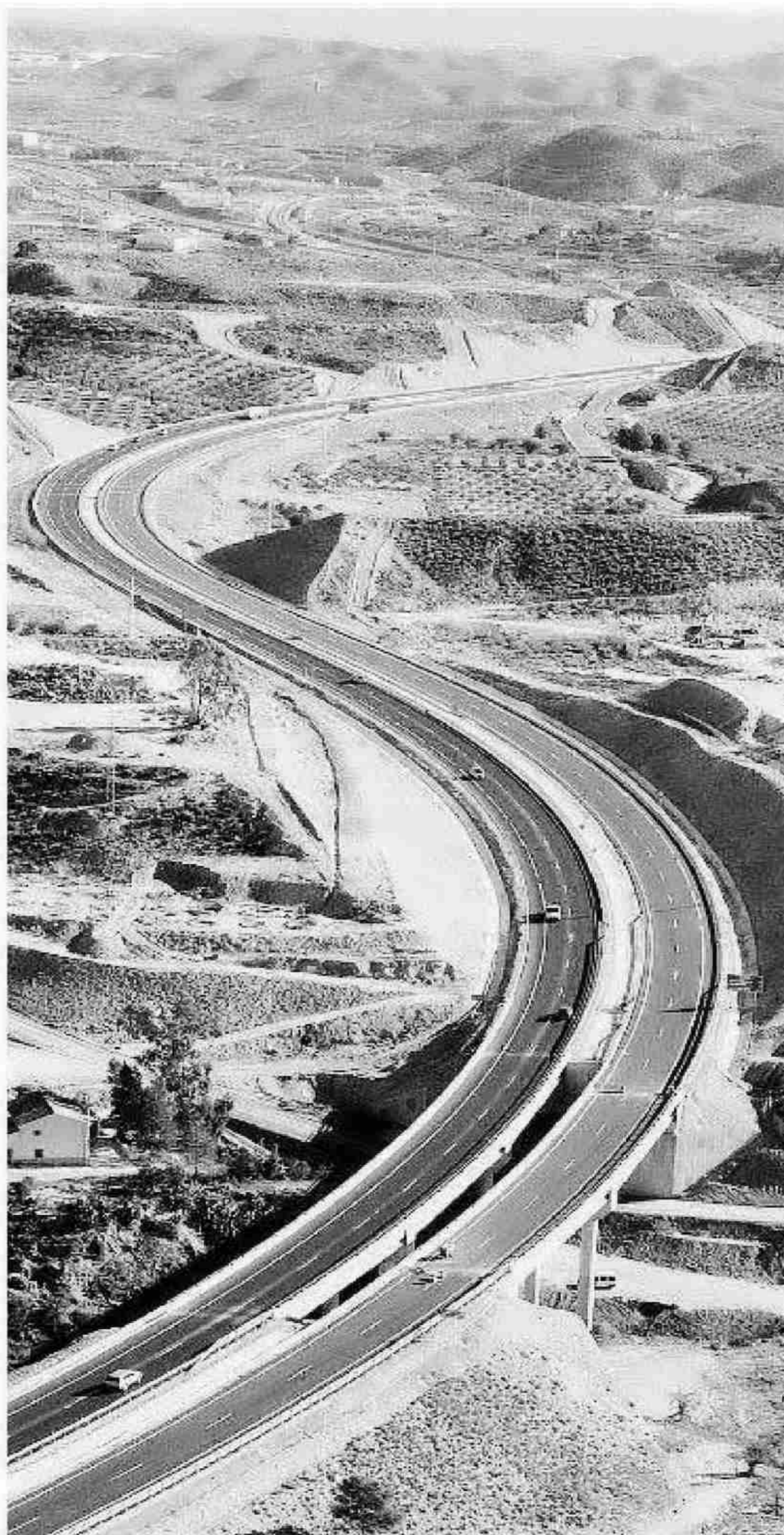
Vista aérea de la Autovía del Almanzora. ✪ IDEAL
