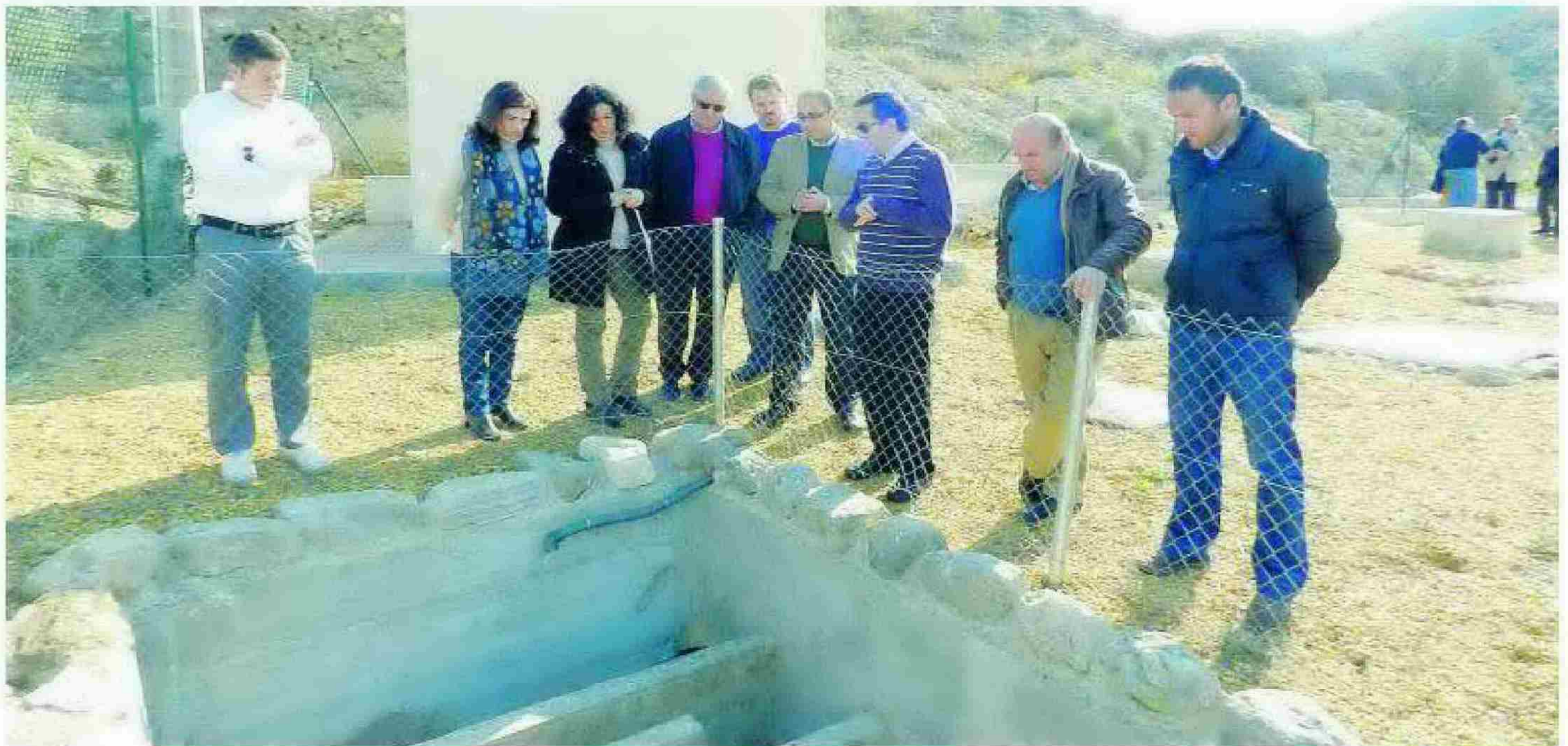
Las autoridades observan cómo funciona la depuradora de Almajalejo en Huércal Overa. :: IDEAL
