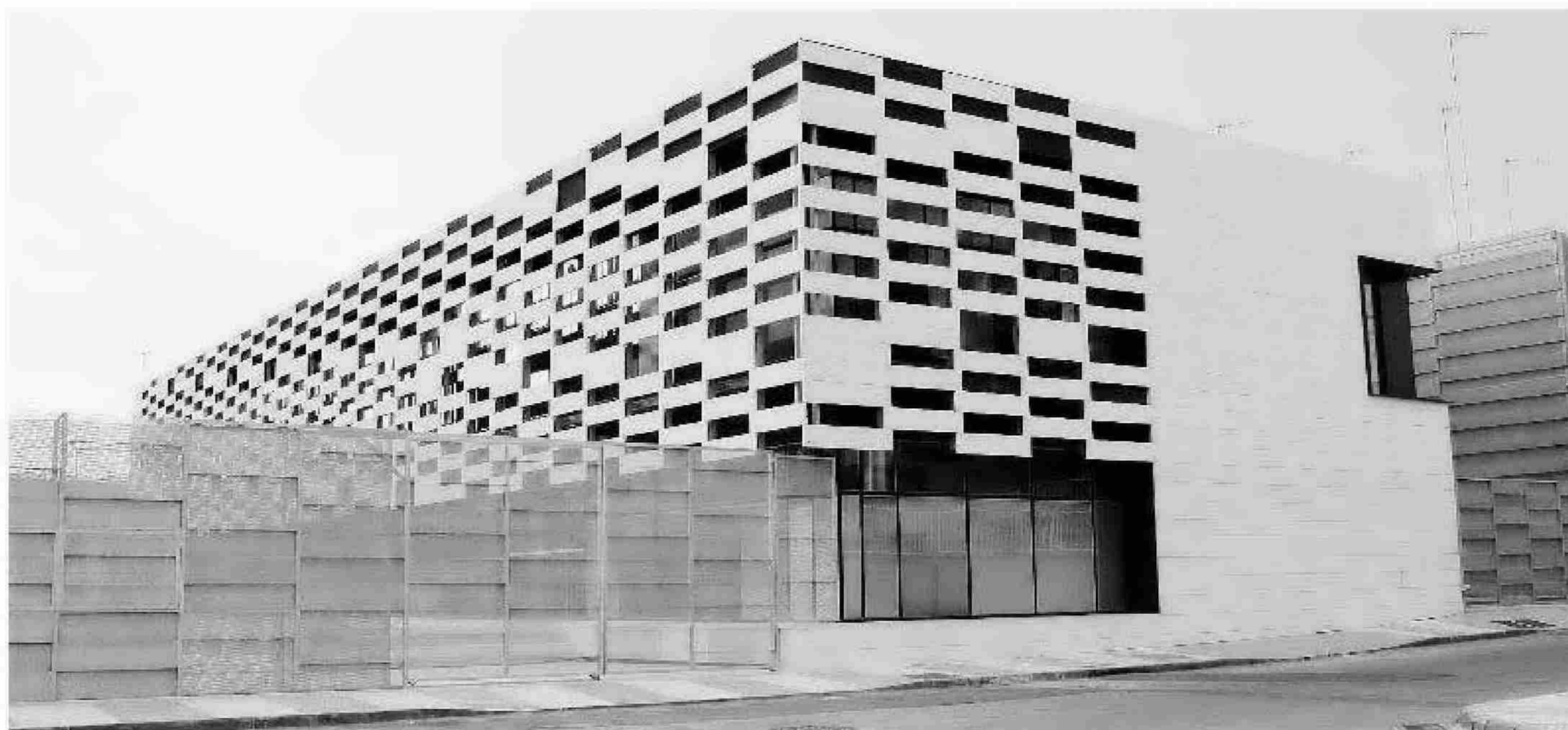
Edificio de la Seguridad Social en Roquetas de Mar. :: J. V.
