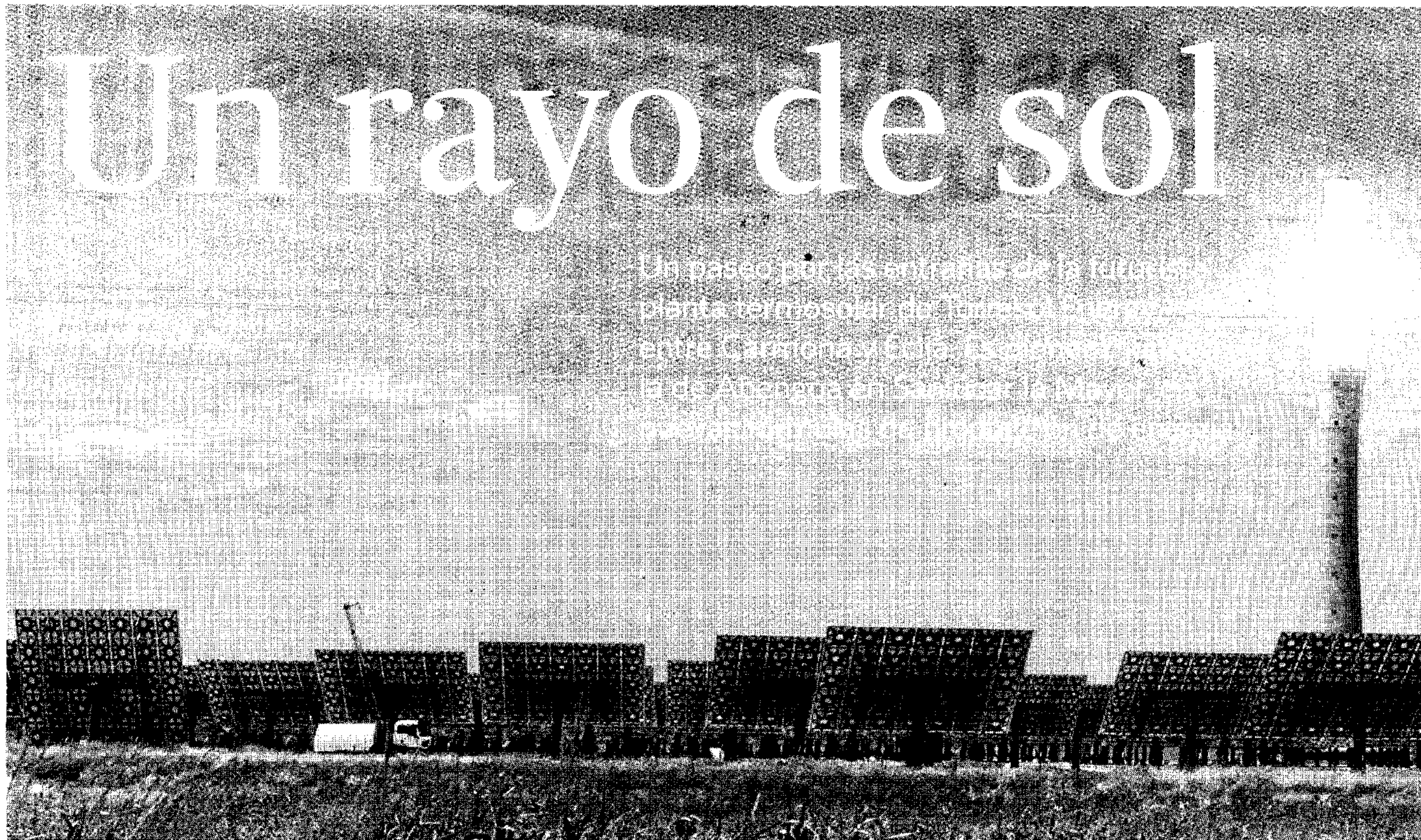
La torre de la planta de Torresol Energy lanza sus haces de luz y rodeada de espejos que capturan la energía solar.
