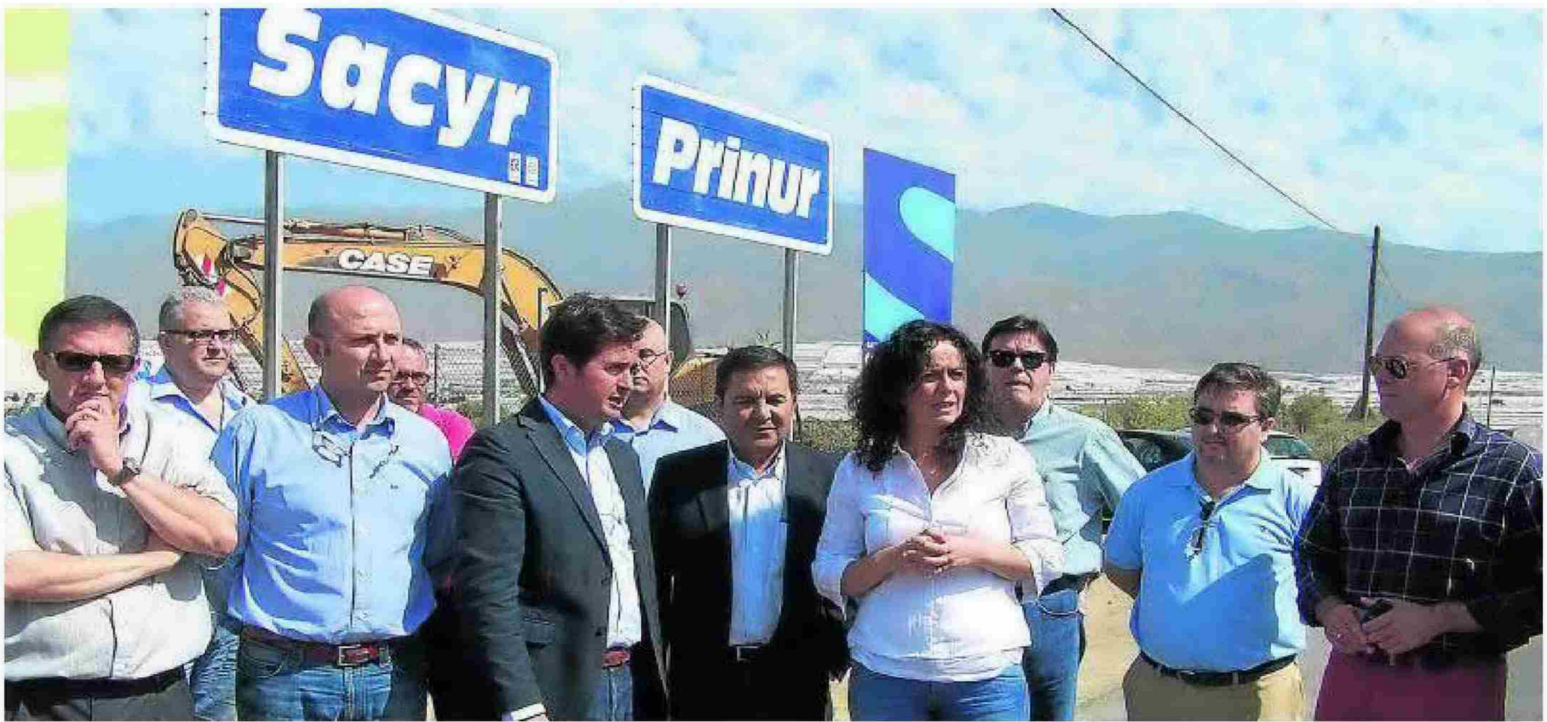
Representantes de la administración autonómica y local visitaron ayer las obras, en su primera jornada de trabajo. :: A. F. V.
