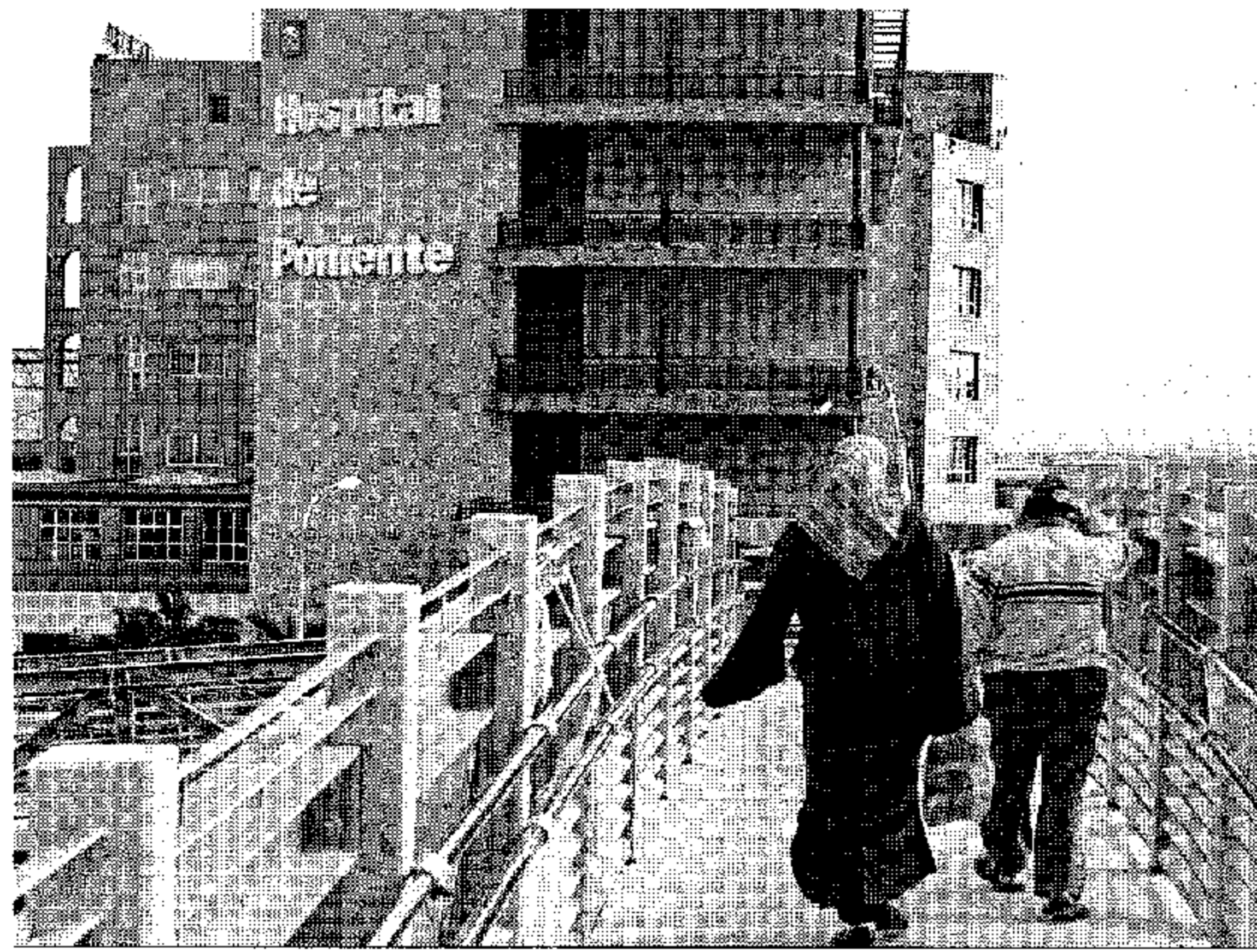
El Hospital de Poniente en El Ejido.
