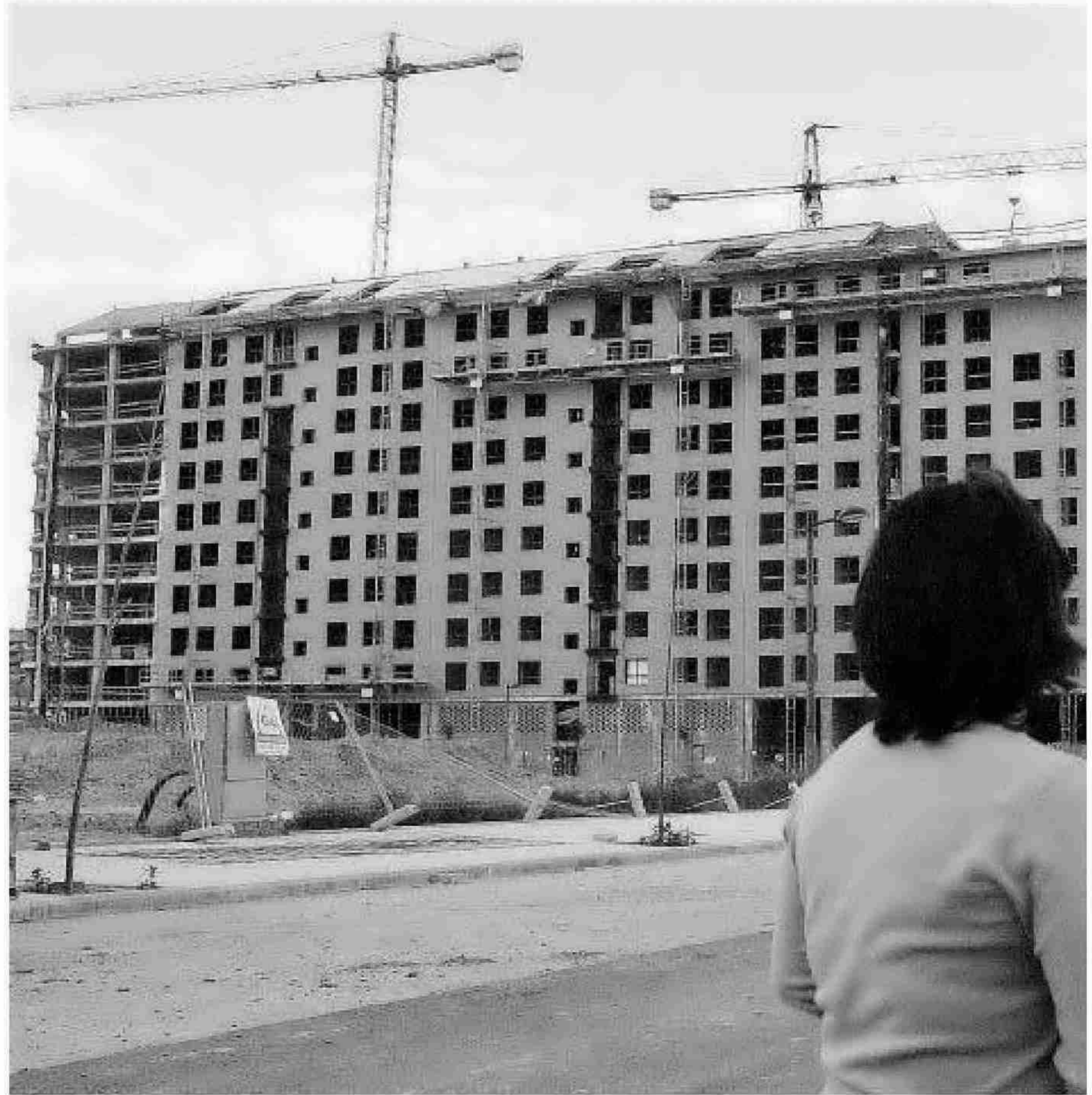
Una pareja de jóvenes observa un bloque de viviendas en construcción. :: DAMIÁN TORRES
