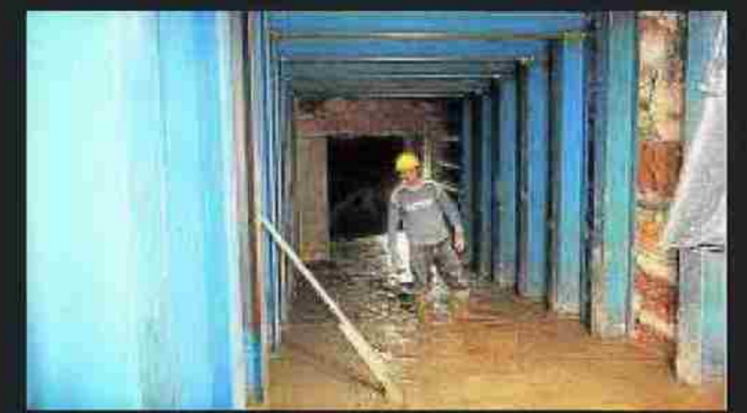
Operario, en los últimos retoques.
