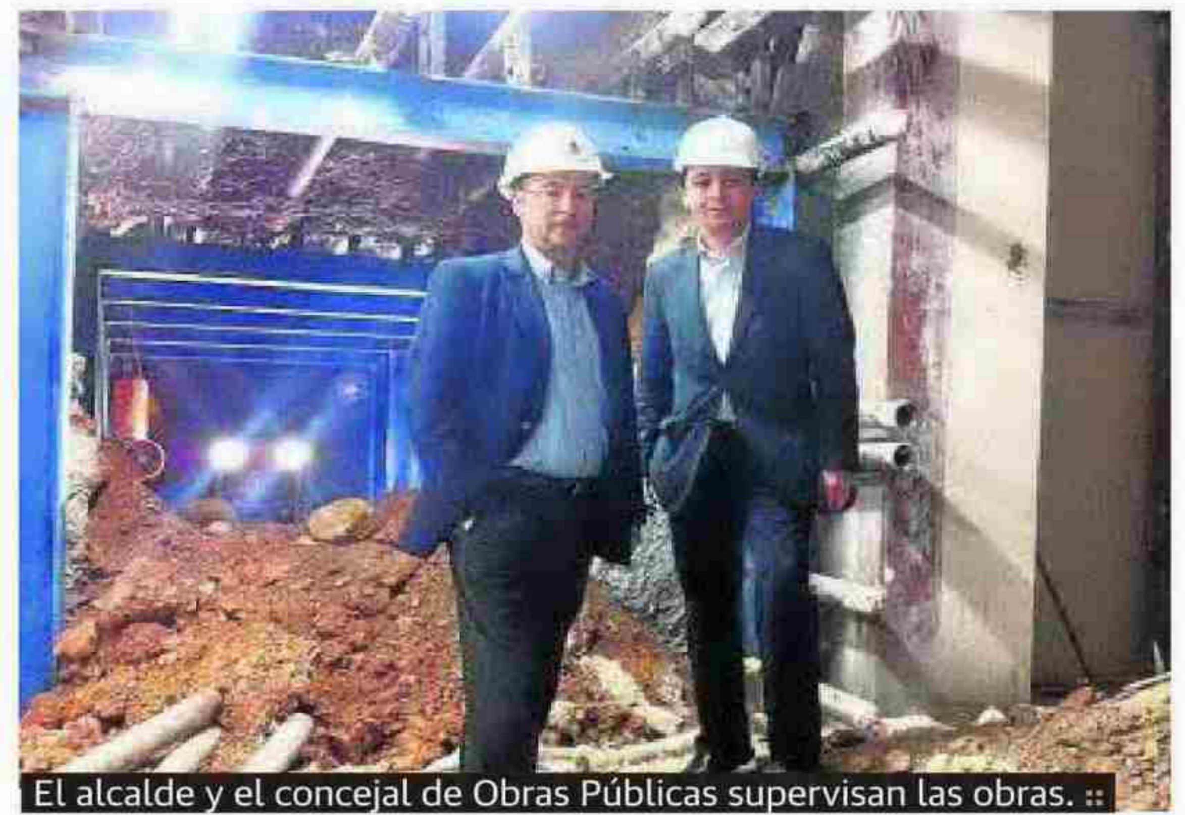
El alcalde y el concejal de Obras Públicas supervisan las obras. ::
