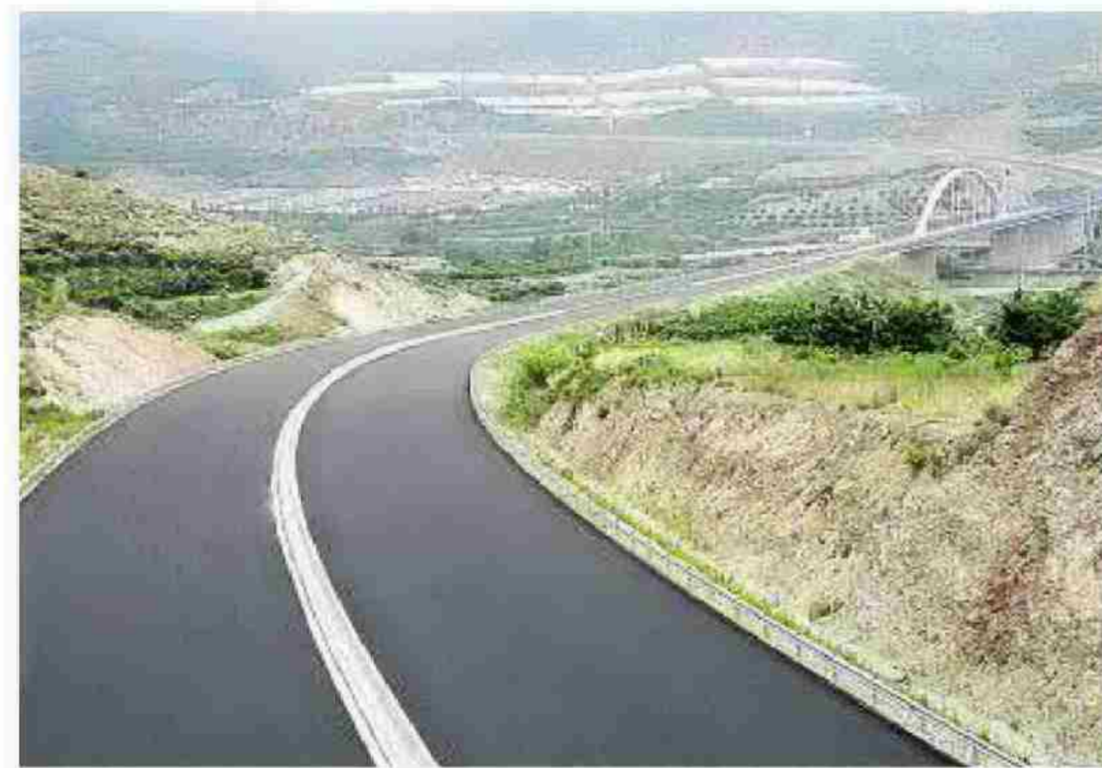
Tramos acabado del autovía A-7 entre Lobres y Guadalfeo. :: J. MARTÍN
