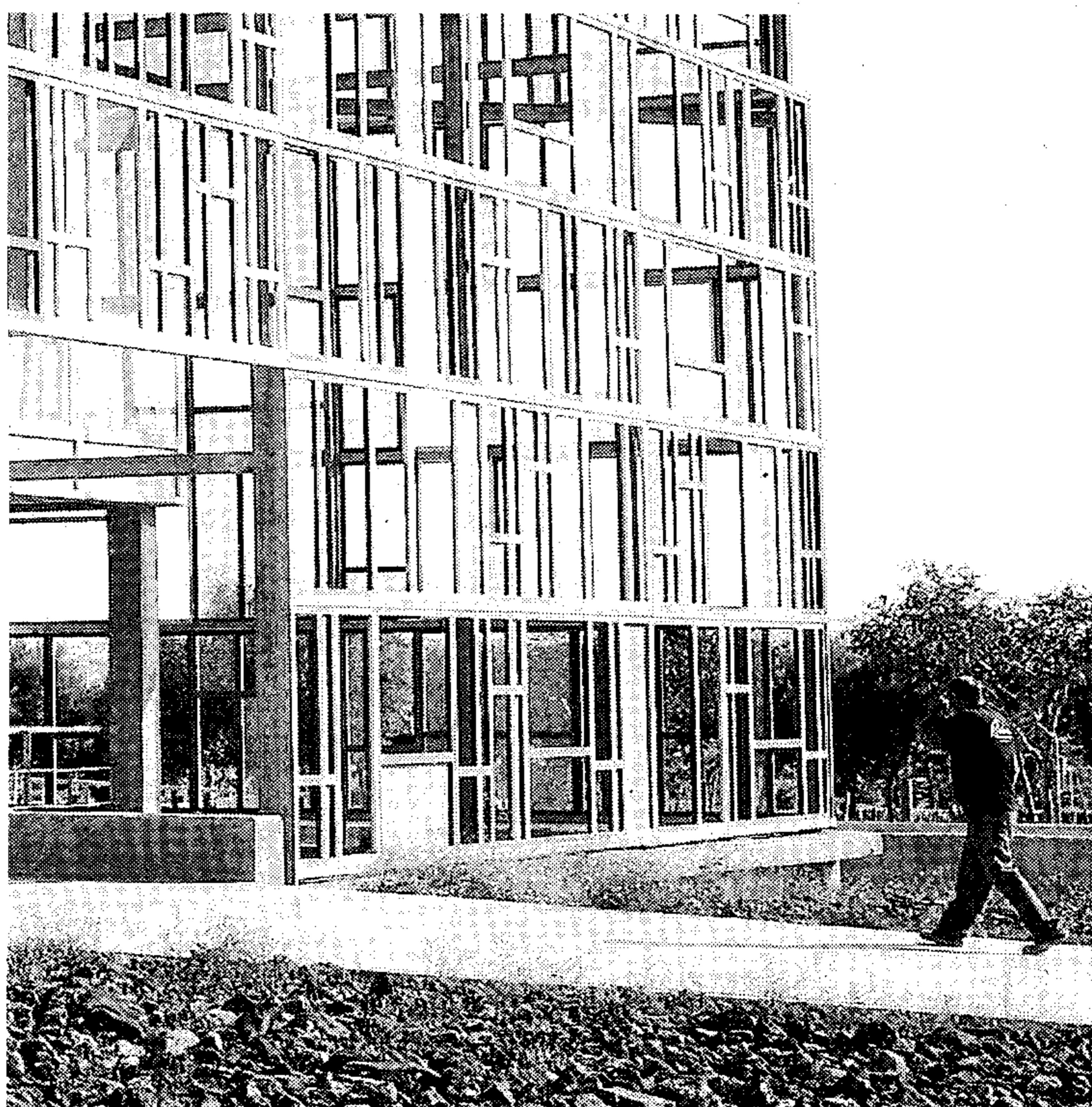
Un trabajador recorre el pasillo de entrada a la Ciudad Digital
