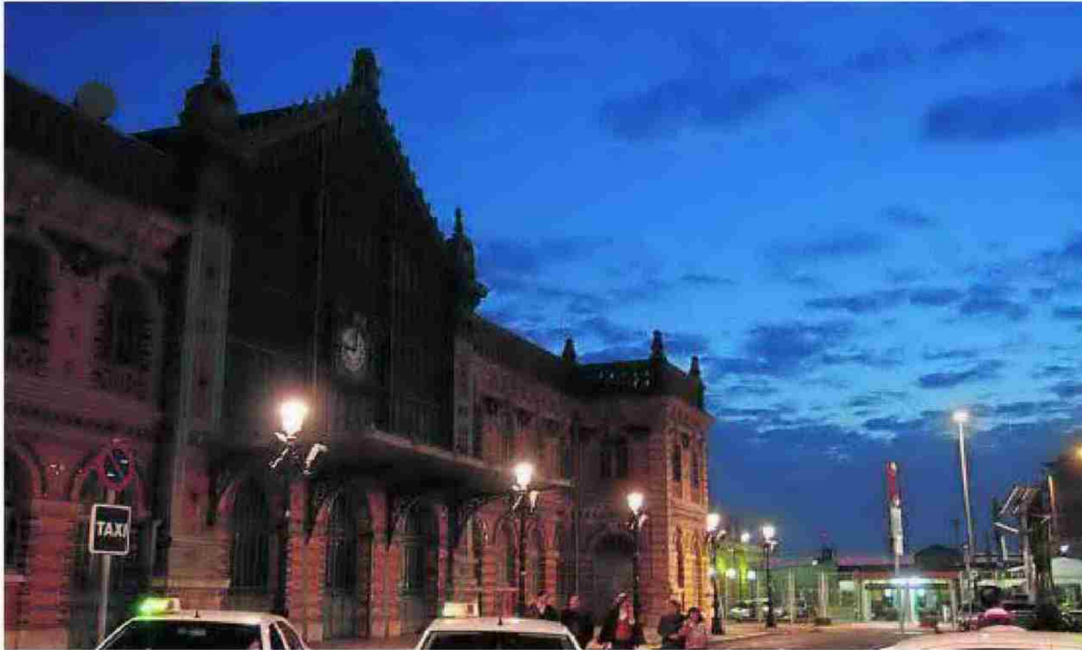
La antigua estación de Renfe, en sombras ante la iluminación exterior de la vía pública. :: M. MANZANO
