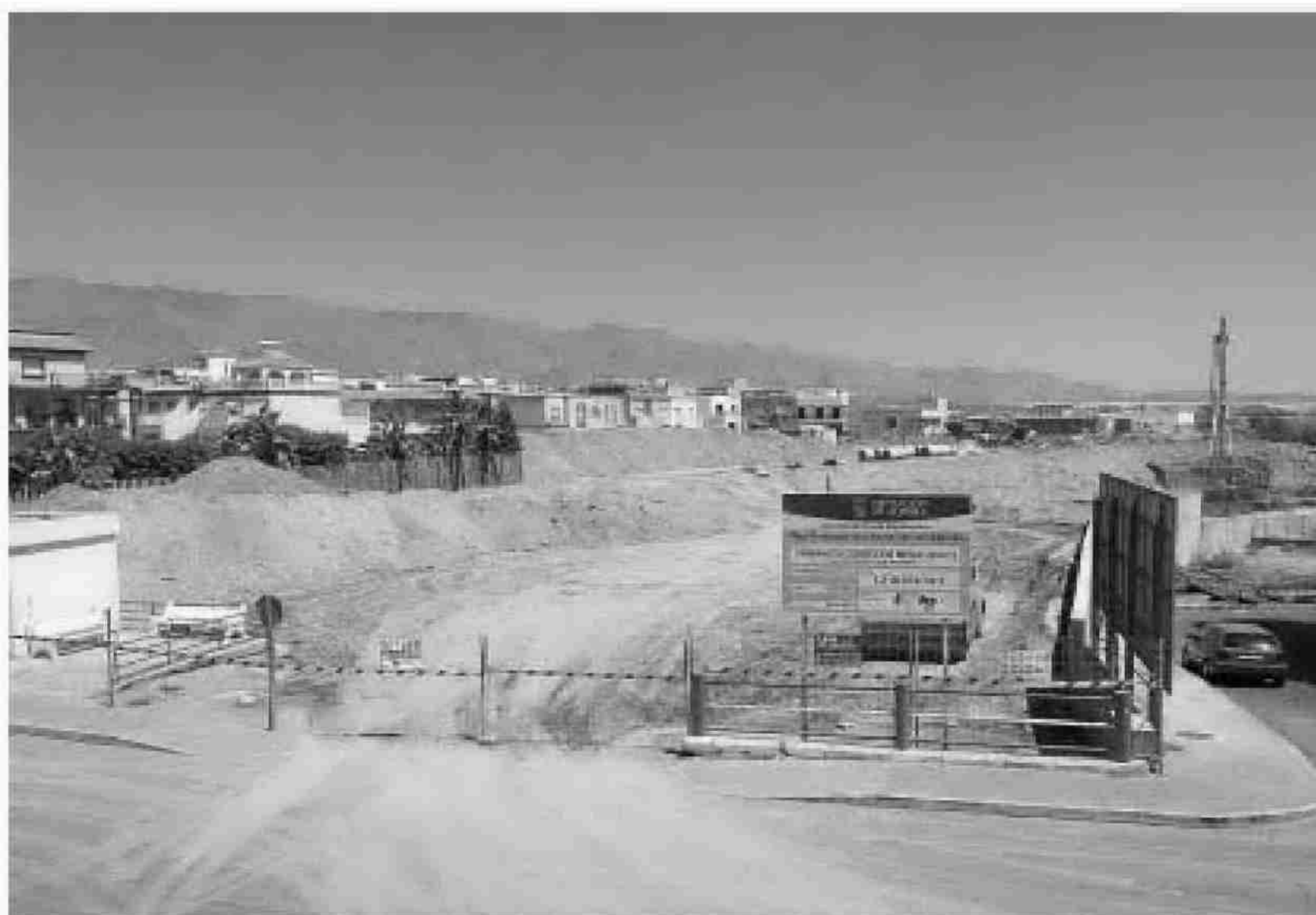
Ya han comenzado los trabajos de movimiento de terrenos.
