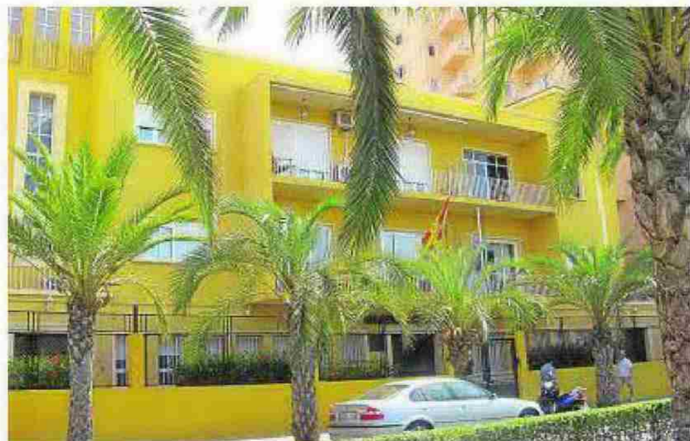
Edificio de la Comandancia Naval de Almería. :: J. T.
