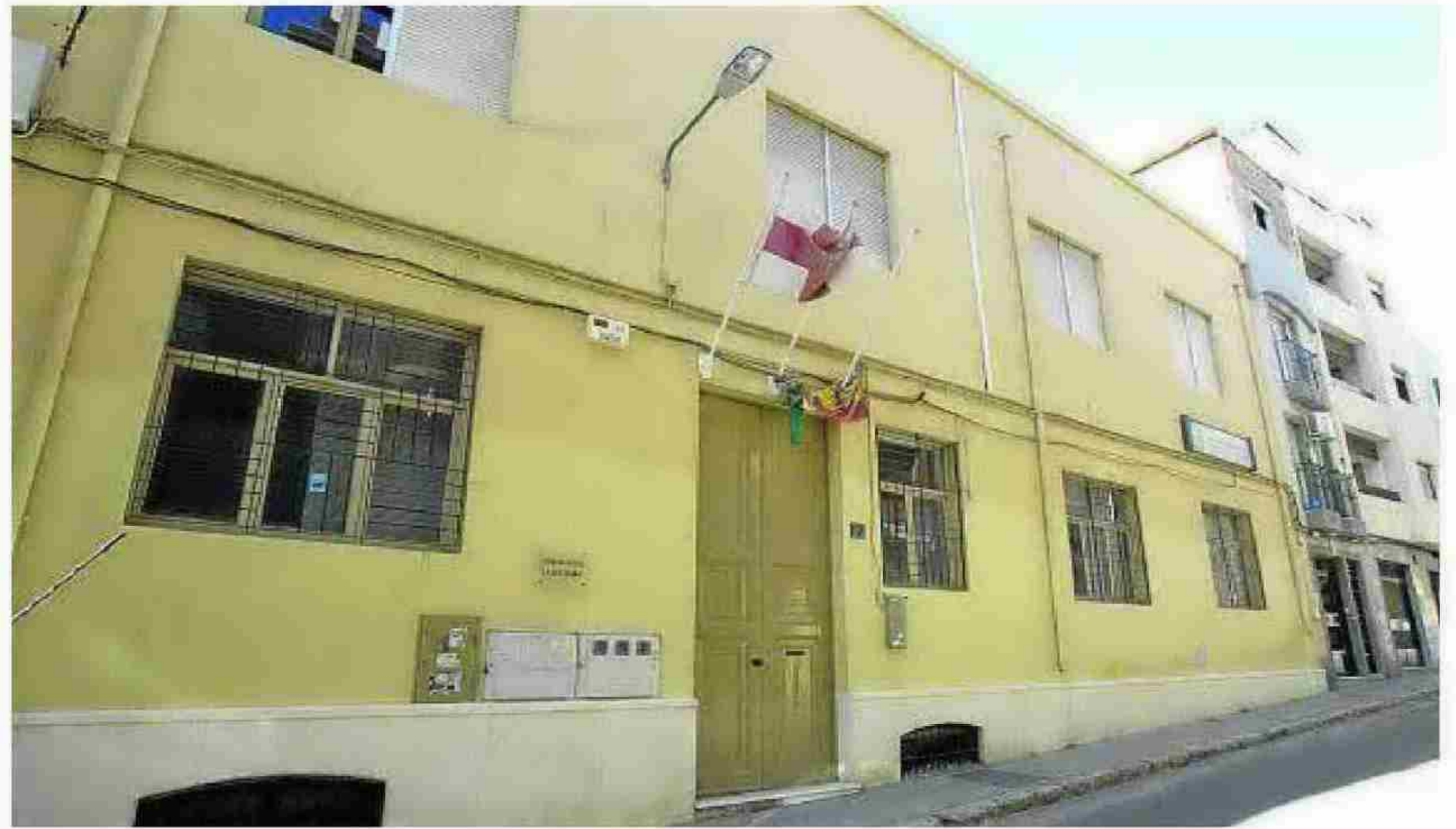
El nuevo centro se ubicará en lo que era la antigua escuela Juan Segura, ahora demolida :: MULLOR
