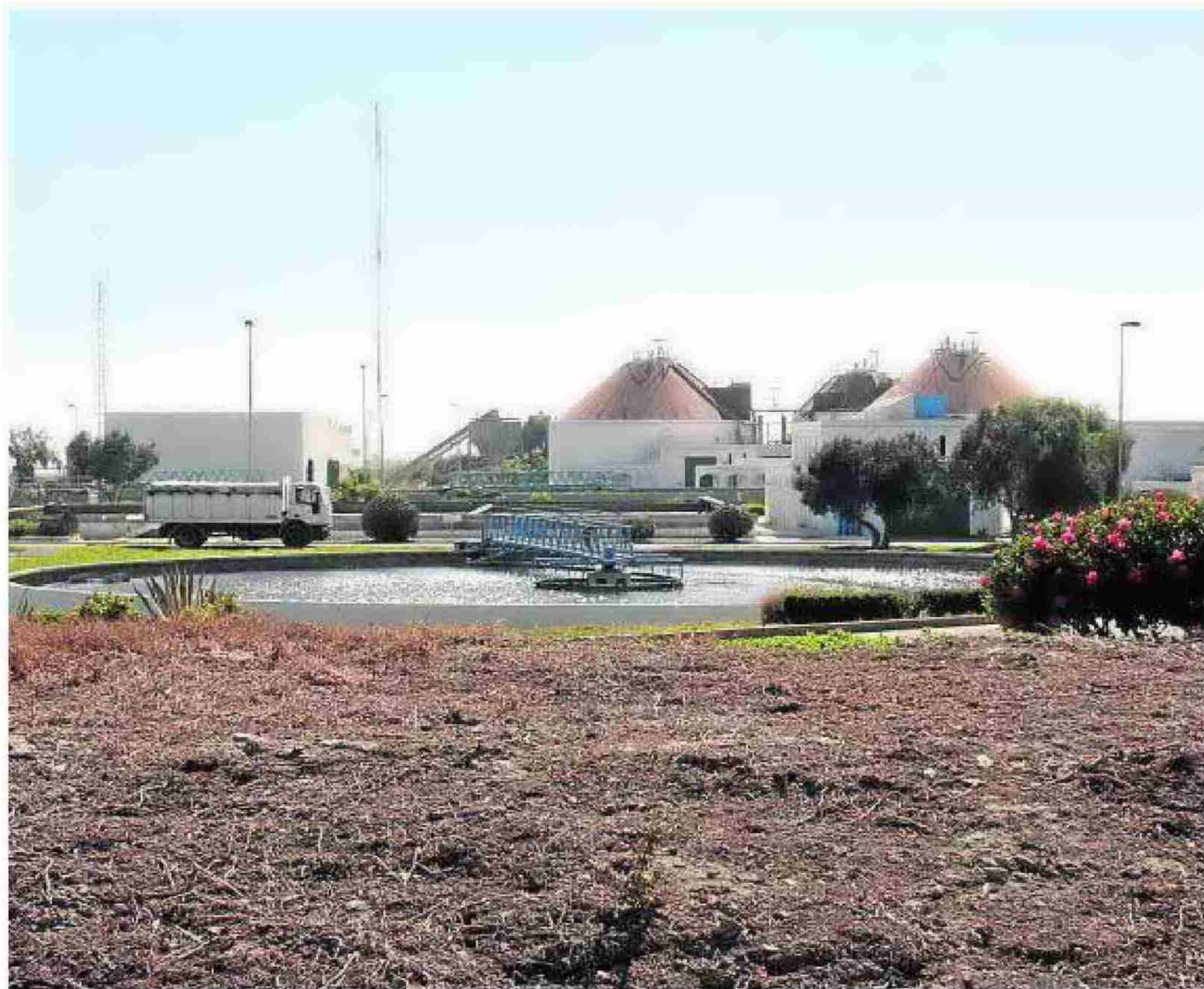
Estación Depuradora de Aguas Residuales de El Bobar, en Almería. :: M. M.
