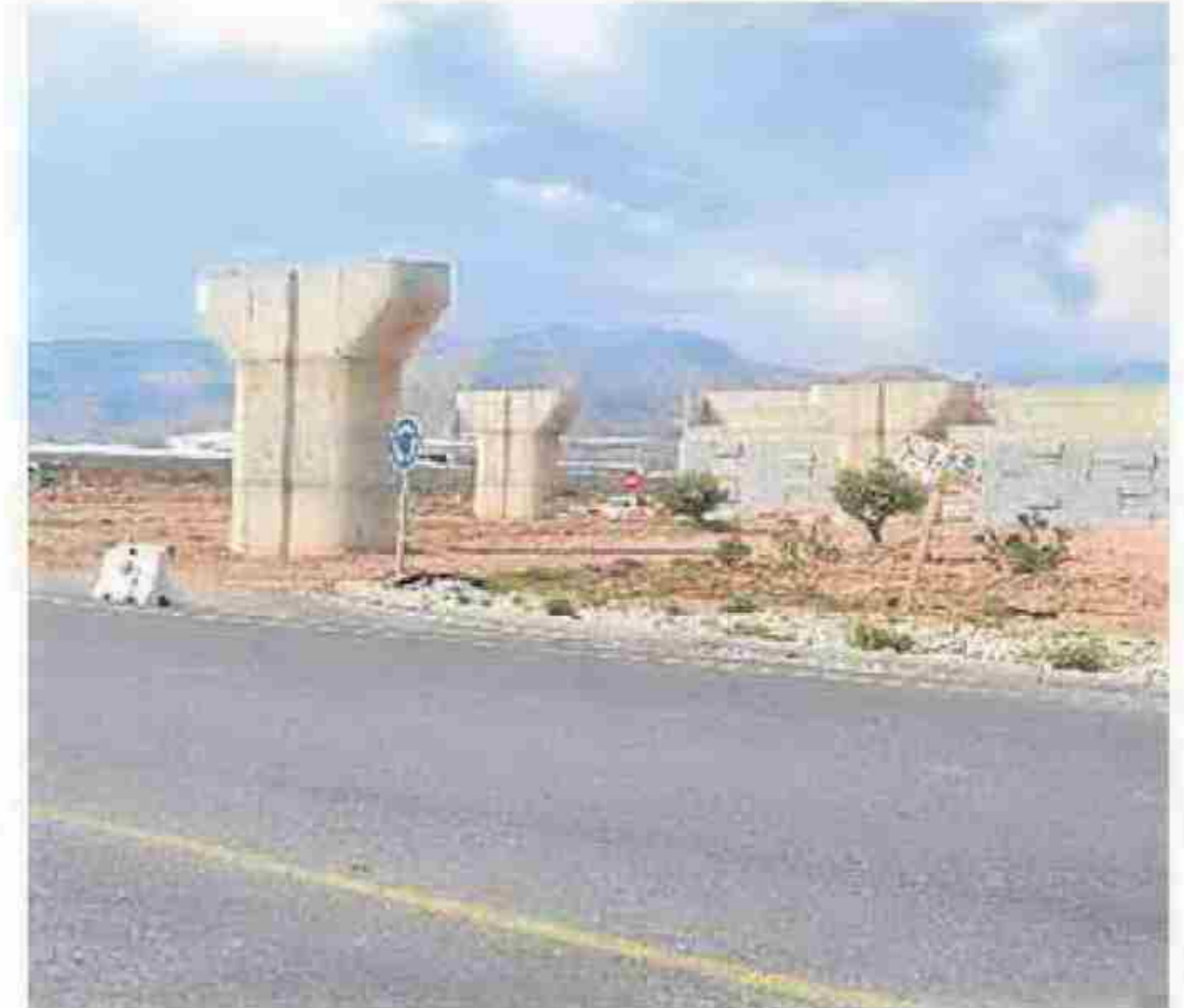
LAS OBRAS de la variante llevan paralizadas 3 años. LA VOZ
