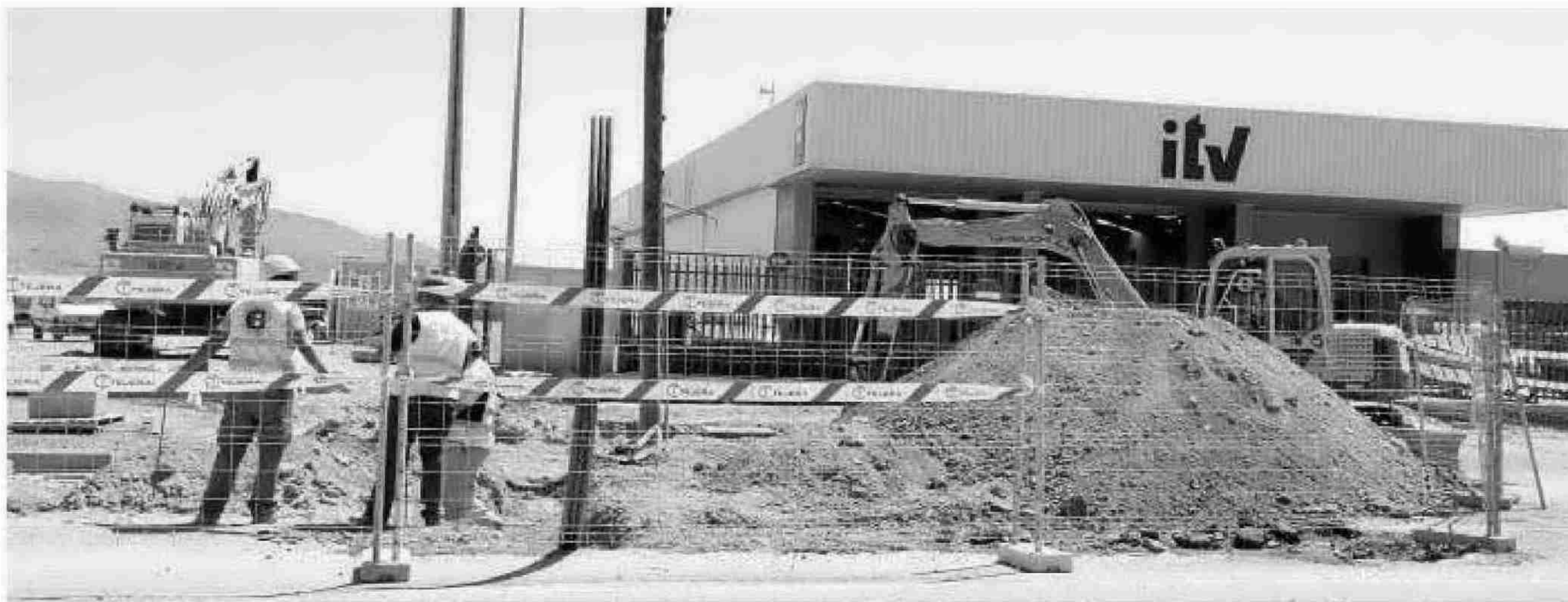
Las obras de urbanización han sitiado la estación de la ITV en el paraje de Zamarula.
