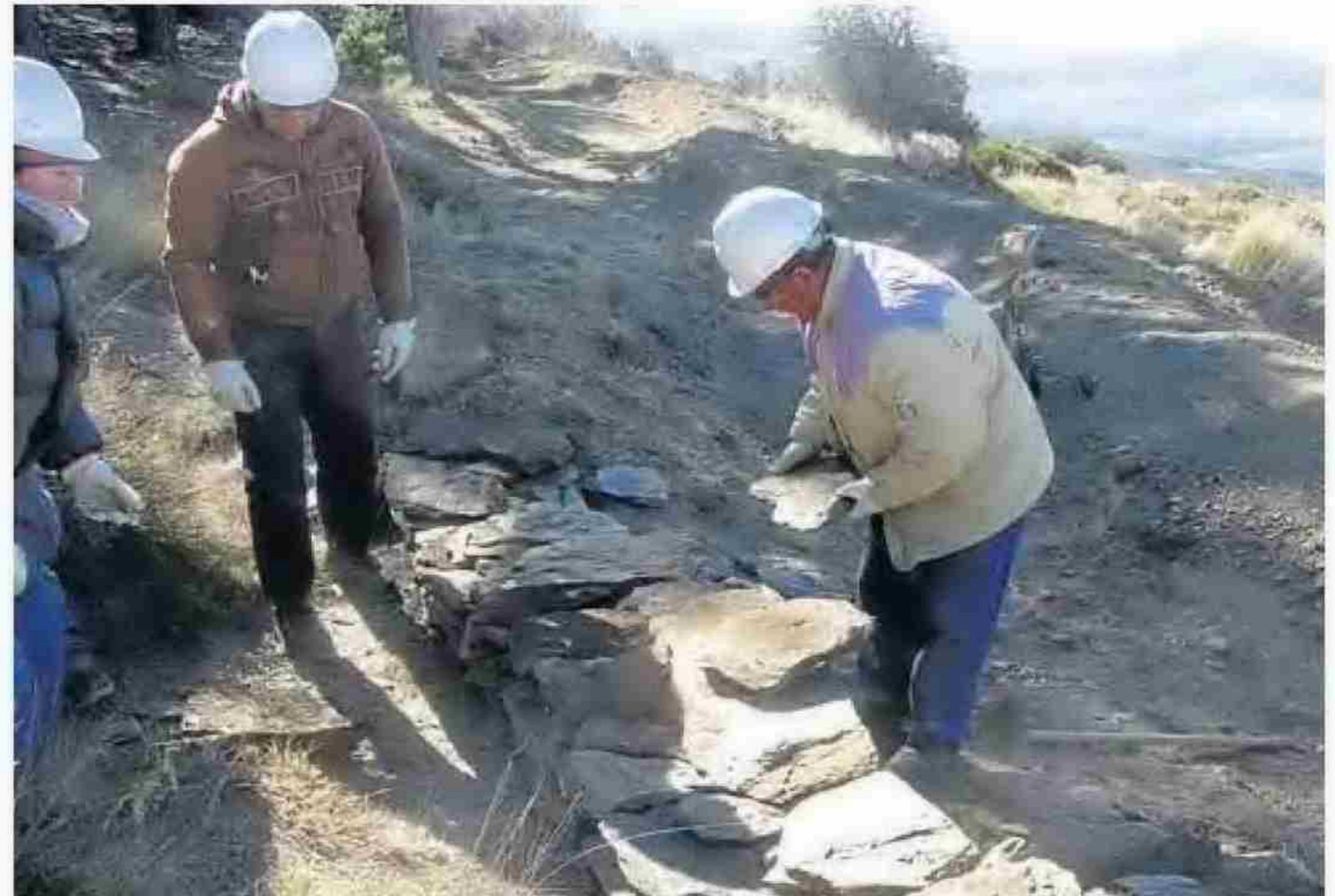
TRABAJADORES durante las tareas de recuperación de una de las acequias. LA VOZ
