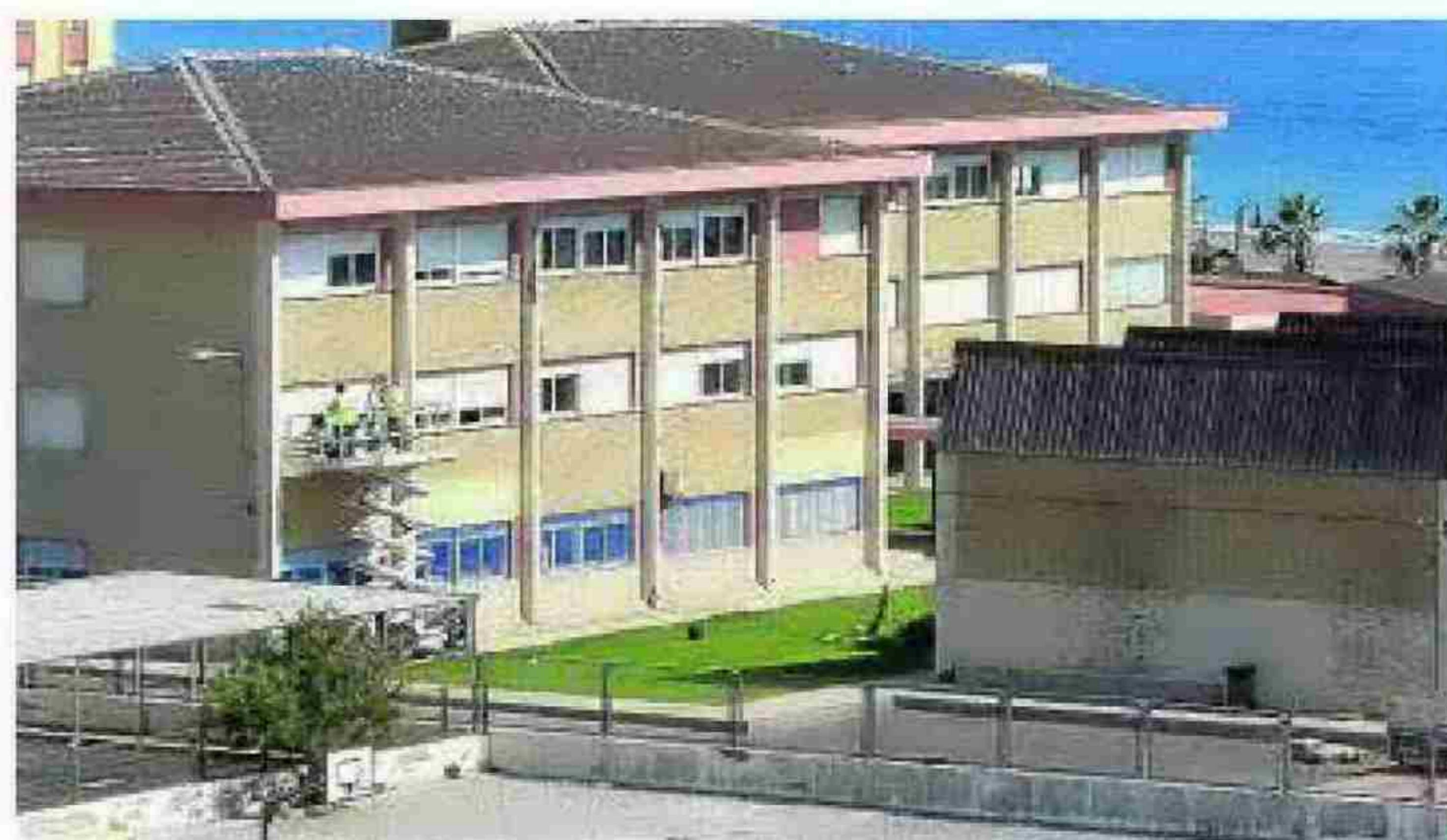
Los trabajos sobre la fachada se desarrollan de forma paralela.
