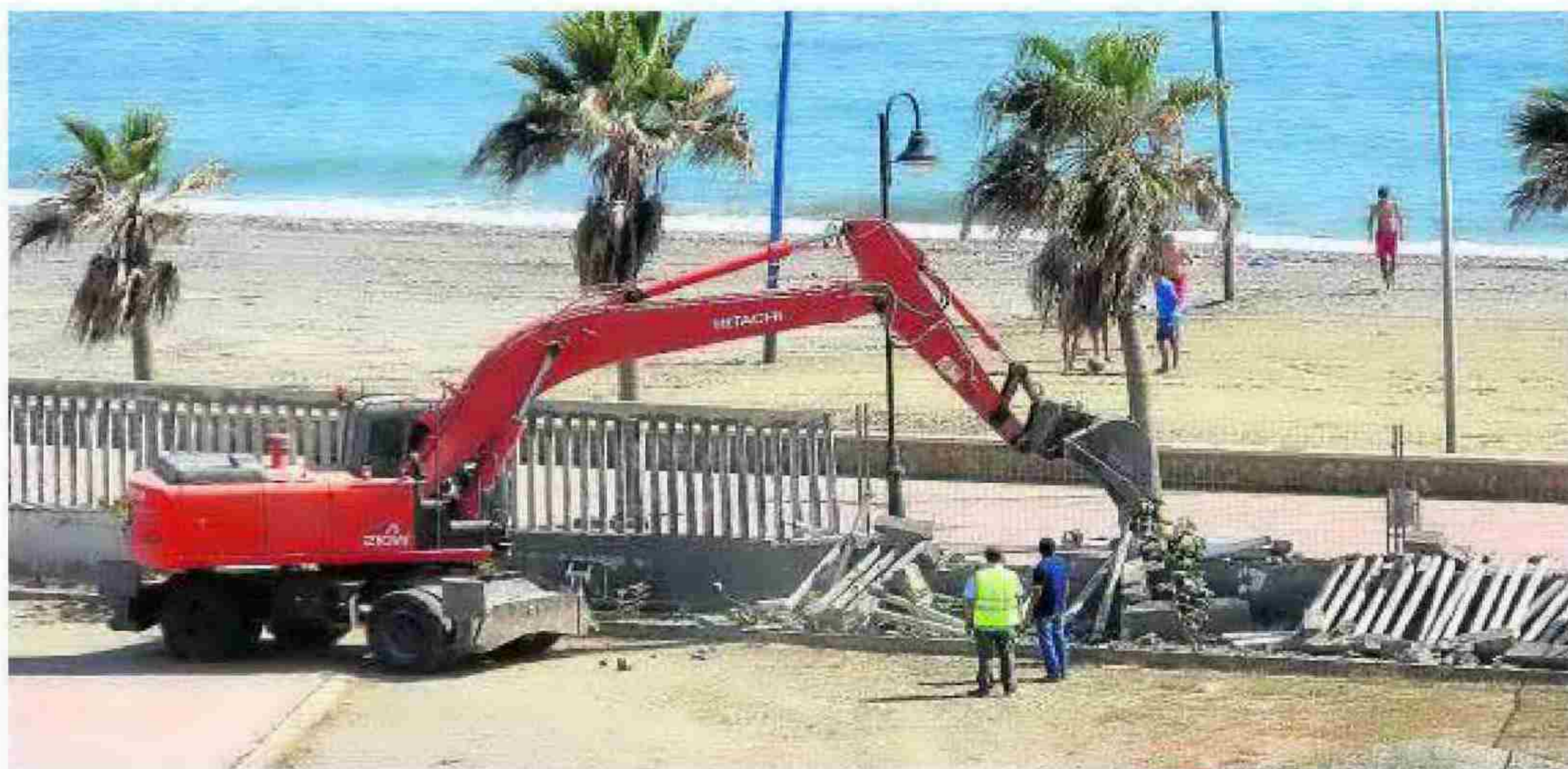
Dos operarios supervisan la demolición del vallado que limita el perímetro del centro. :: M.TORRES
