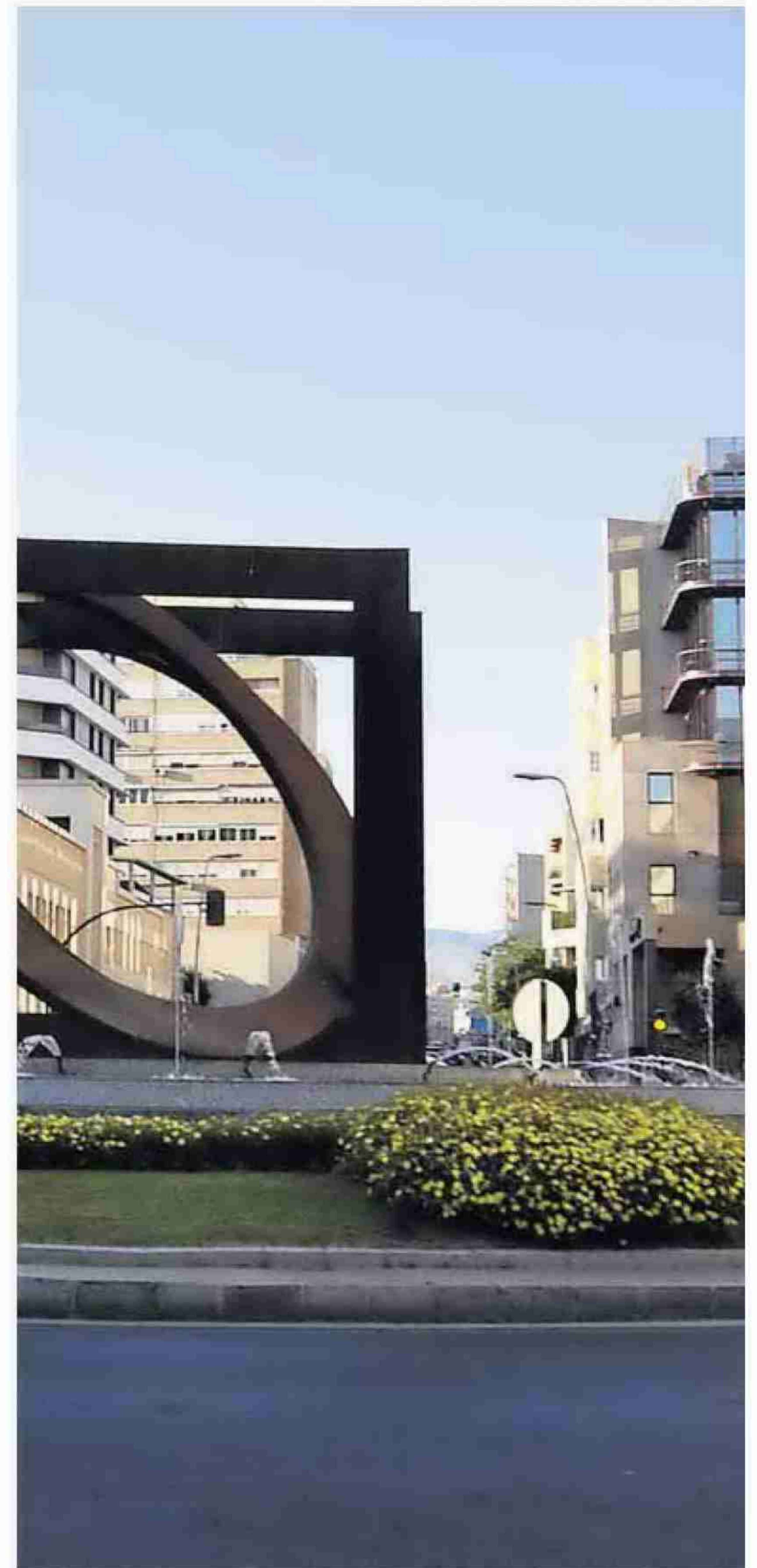
SEDE de Cajamar Caja Rural en la plaza de Barcelona. LA VOZ
