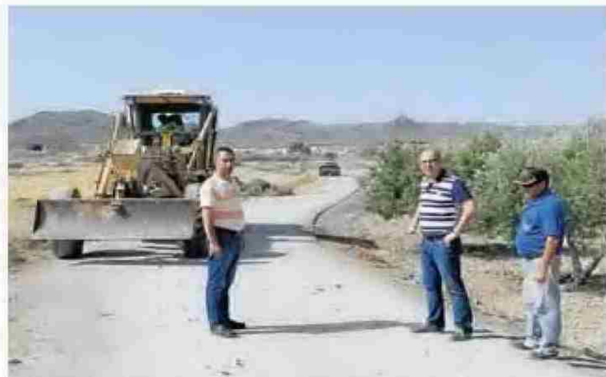
VISITA del alcalde y concejal a las obras. LA VOZ
