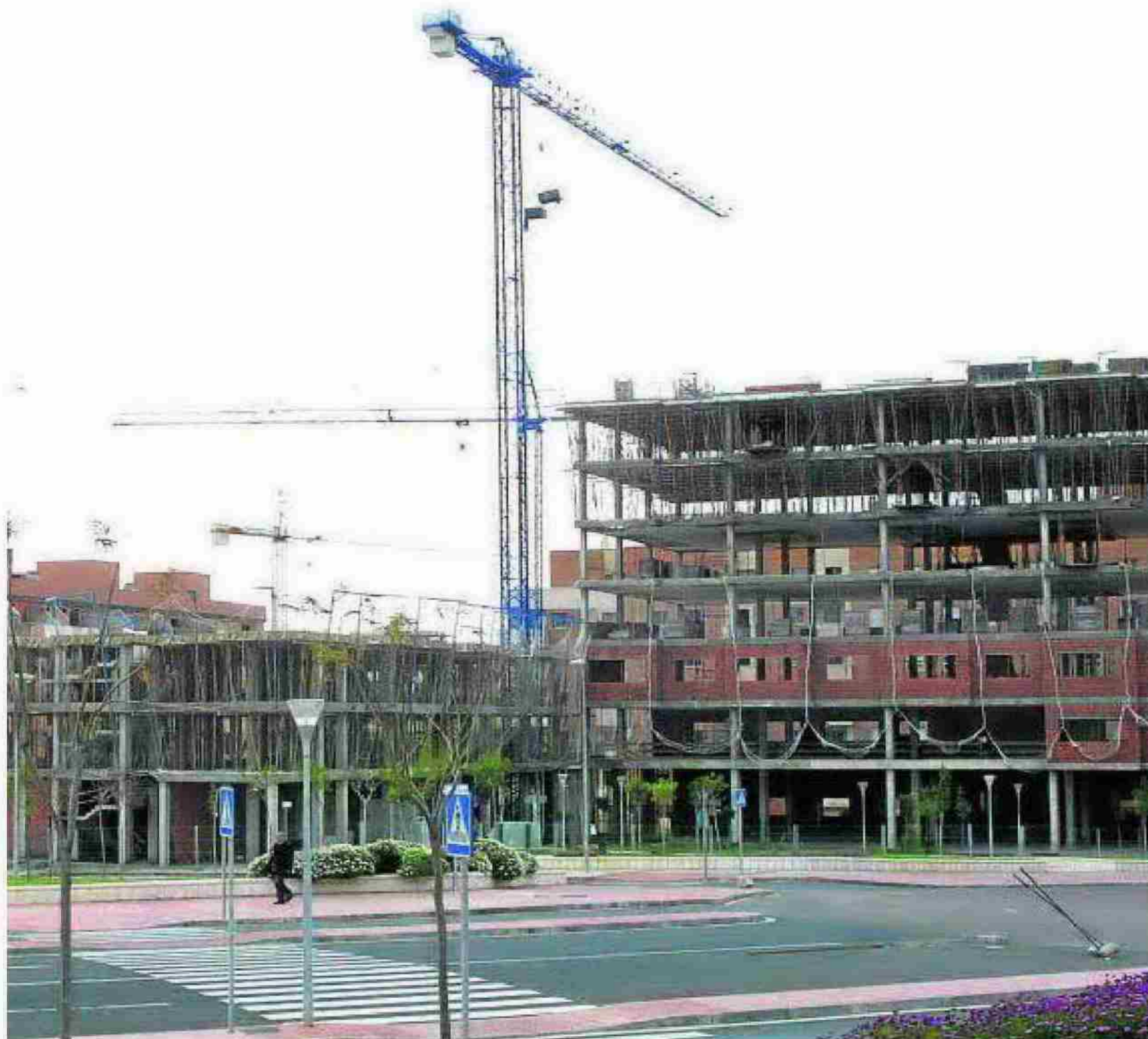
Viviendas en construcción en un barrio de expansión de Almería capital. :: M. M.
