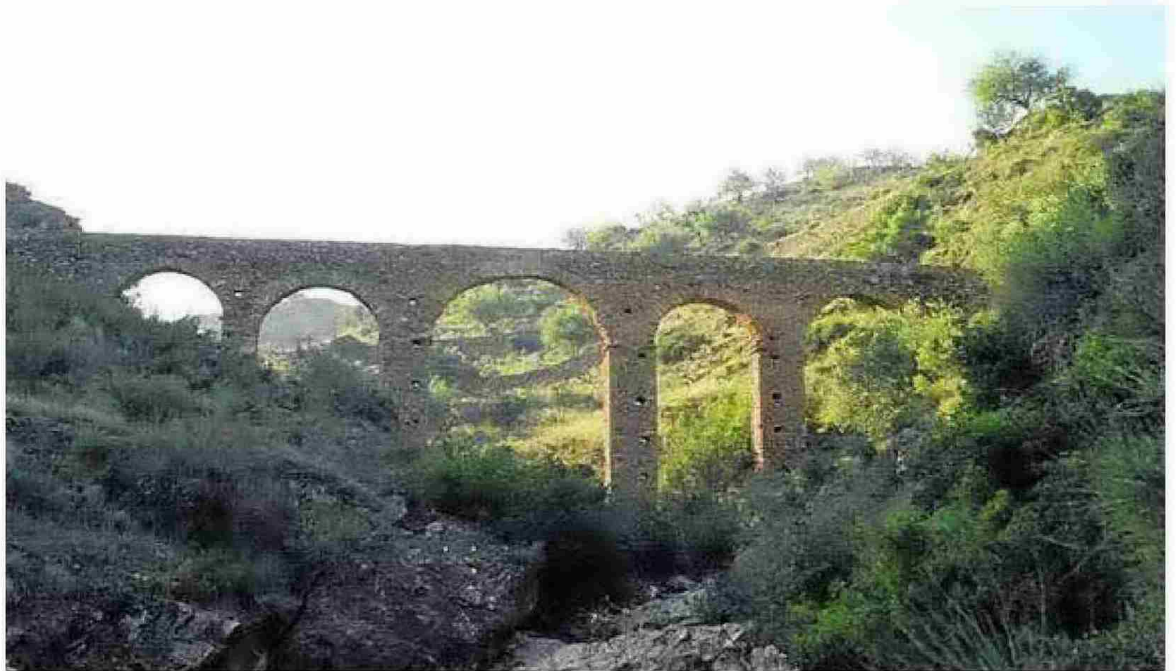
Vista de un acueducto en la provincia. :: IDEAL
