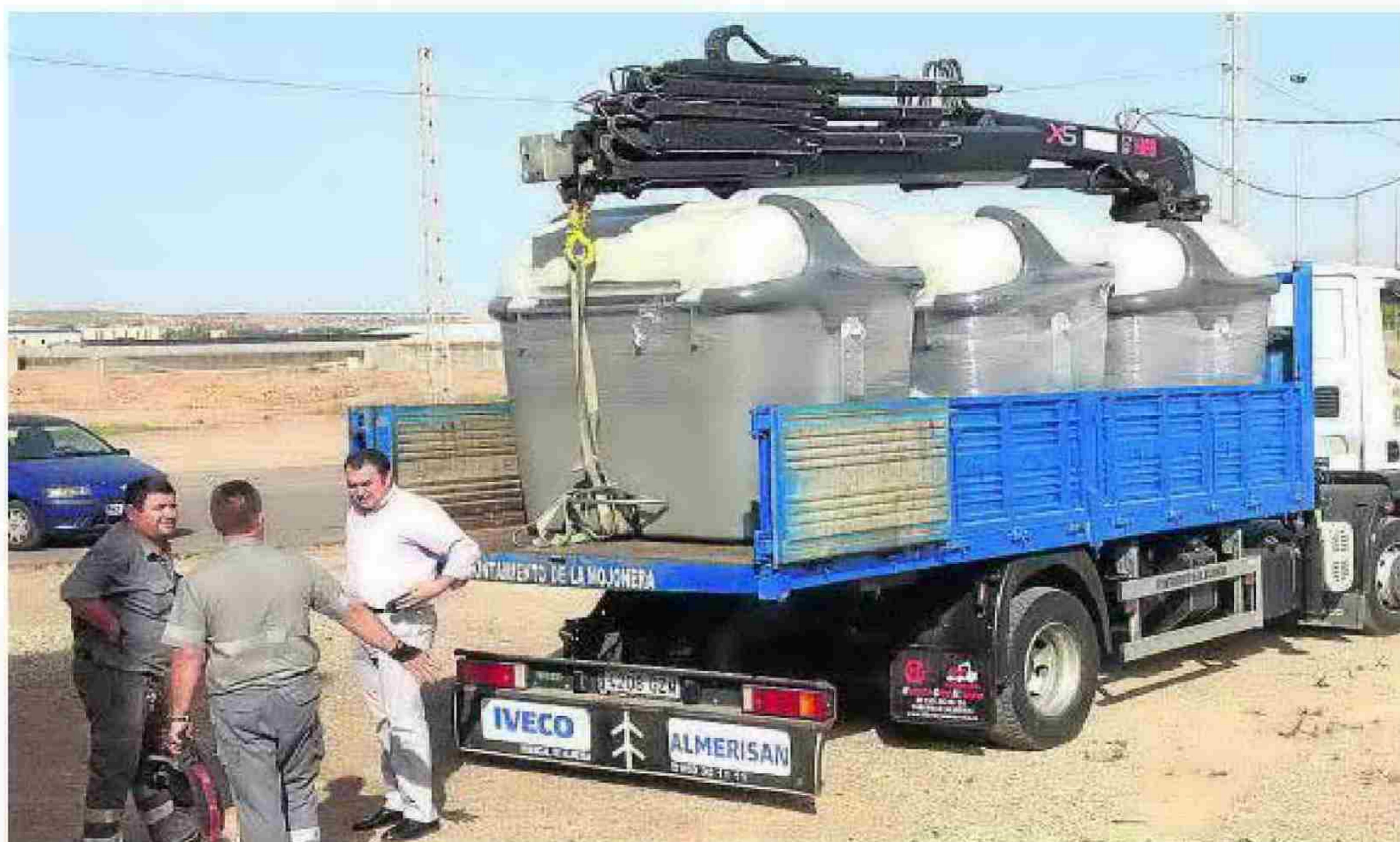
Encargados de la instalación de contenedores explican al alcalde José Cara donde irán colocados. :: F. G.
