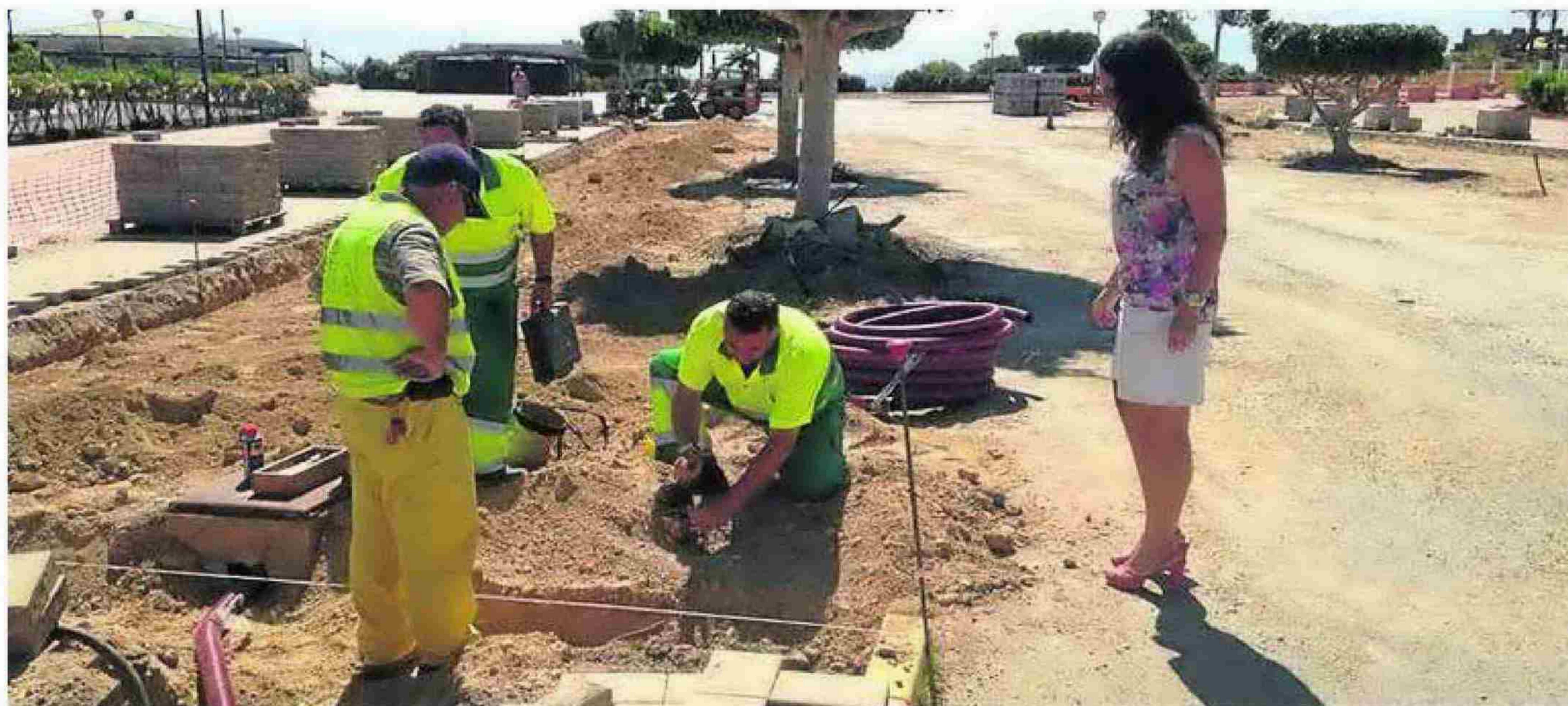
Operarios, trabajando en las vías de Vera Playa, mientras la concejala comprueba cómo se desarrollan los trabajos. :: IDEAL
