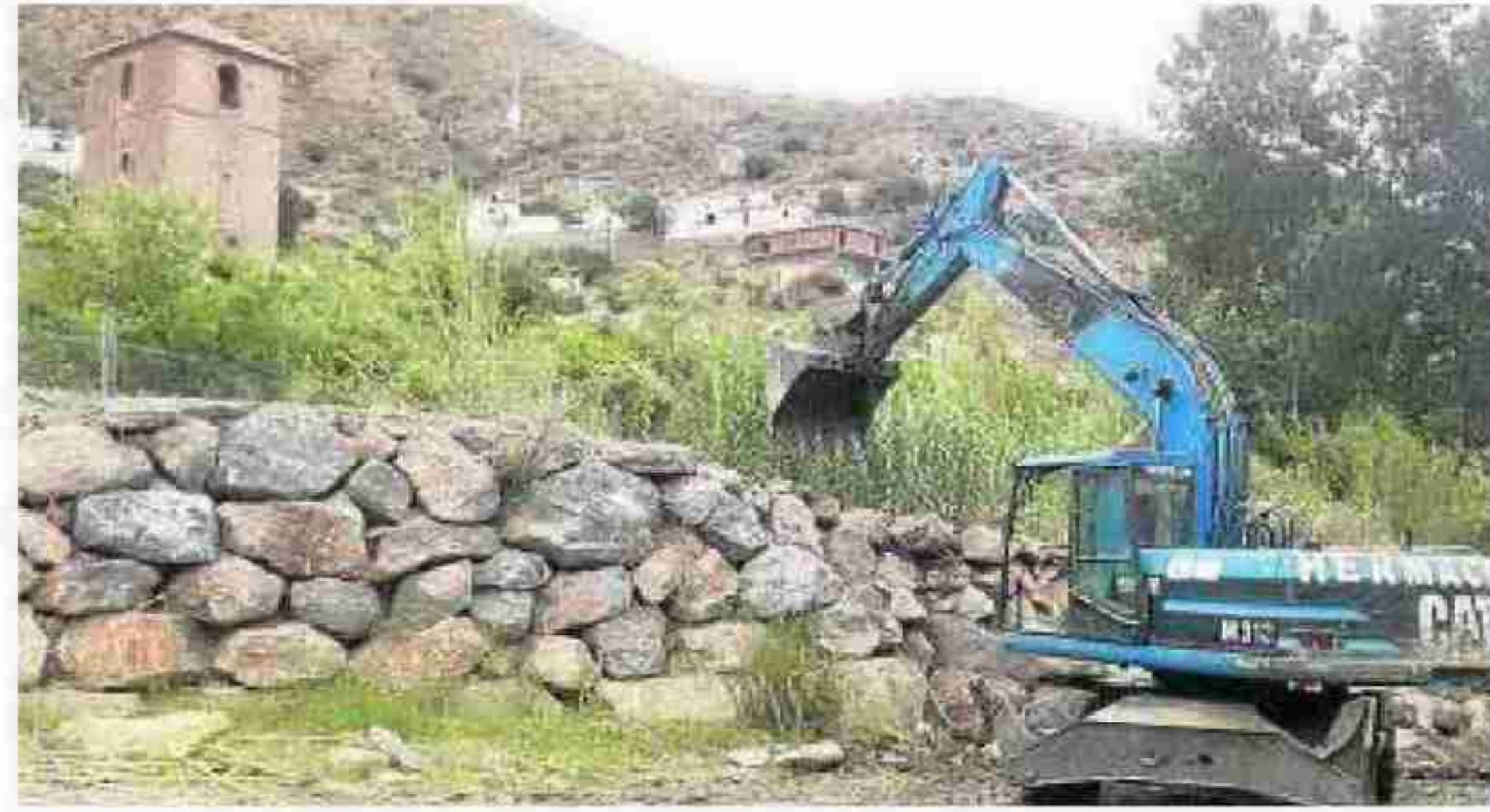
Una excavadora ha iniciado la construcción del muro. :: IDEAL
