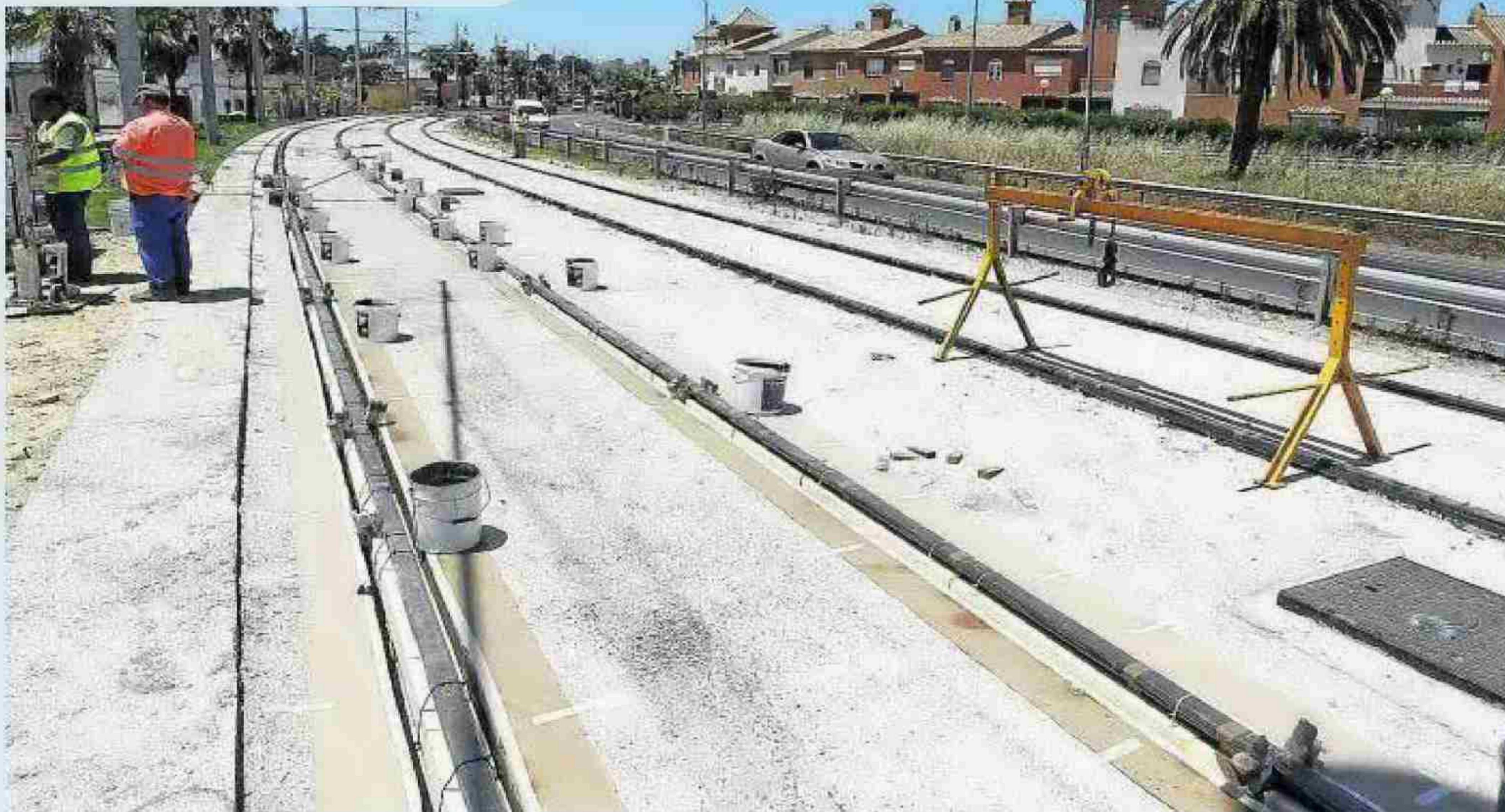
▲ Cádiz. Las obras del tren-tranvía de la bahía gaditana avanzan a buen ritmo en las localidades metropolitanas. :: F. JIMÉNEZ
