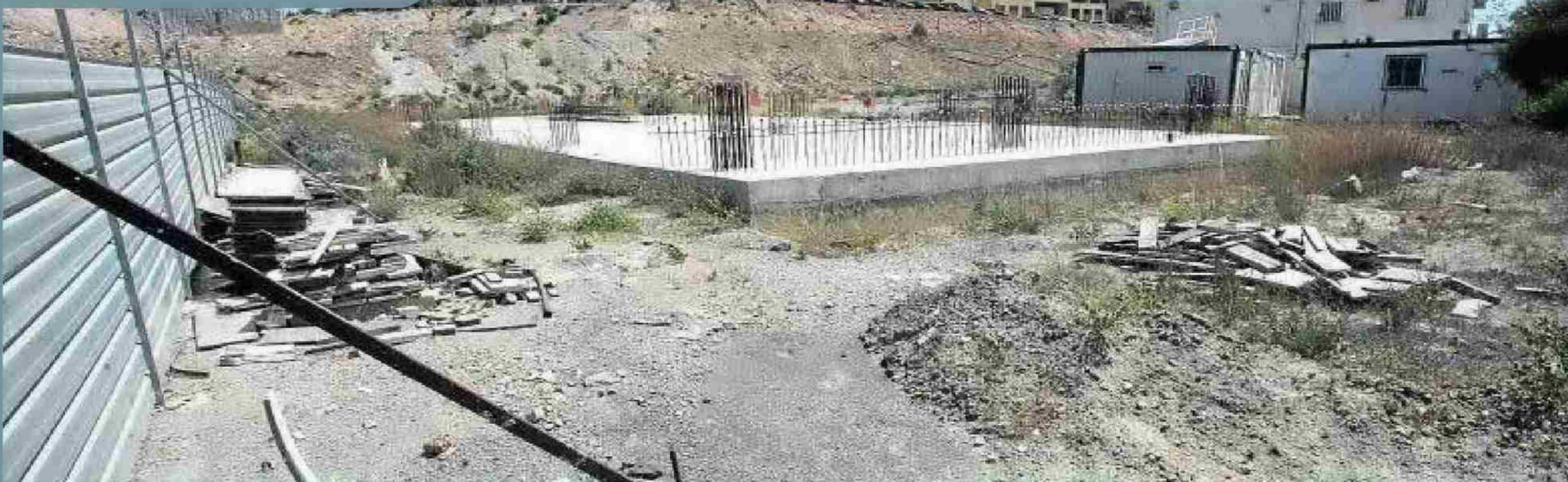
▲ Complejo Hospitalario de Almería. Las obras del Materno-Infantil, que debiera haber entrado en servicio en 2011, paradas. J. J. MULLOR
