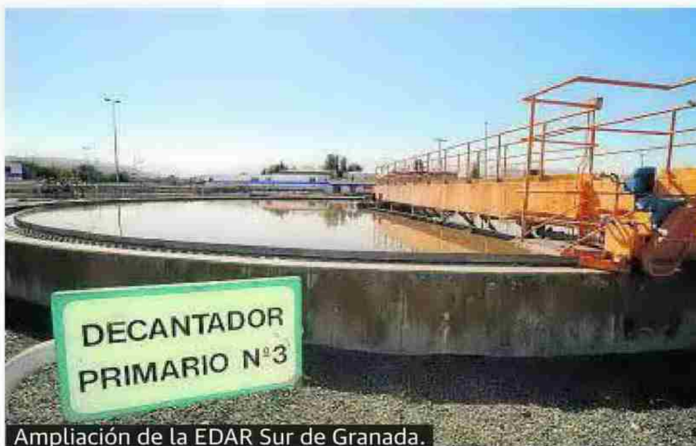
Ampliación de la EDAR Sur de Granada.
