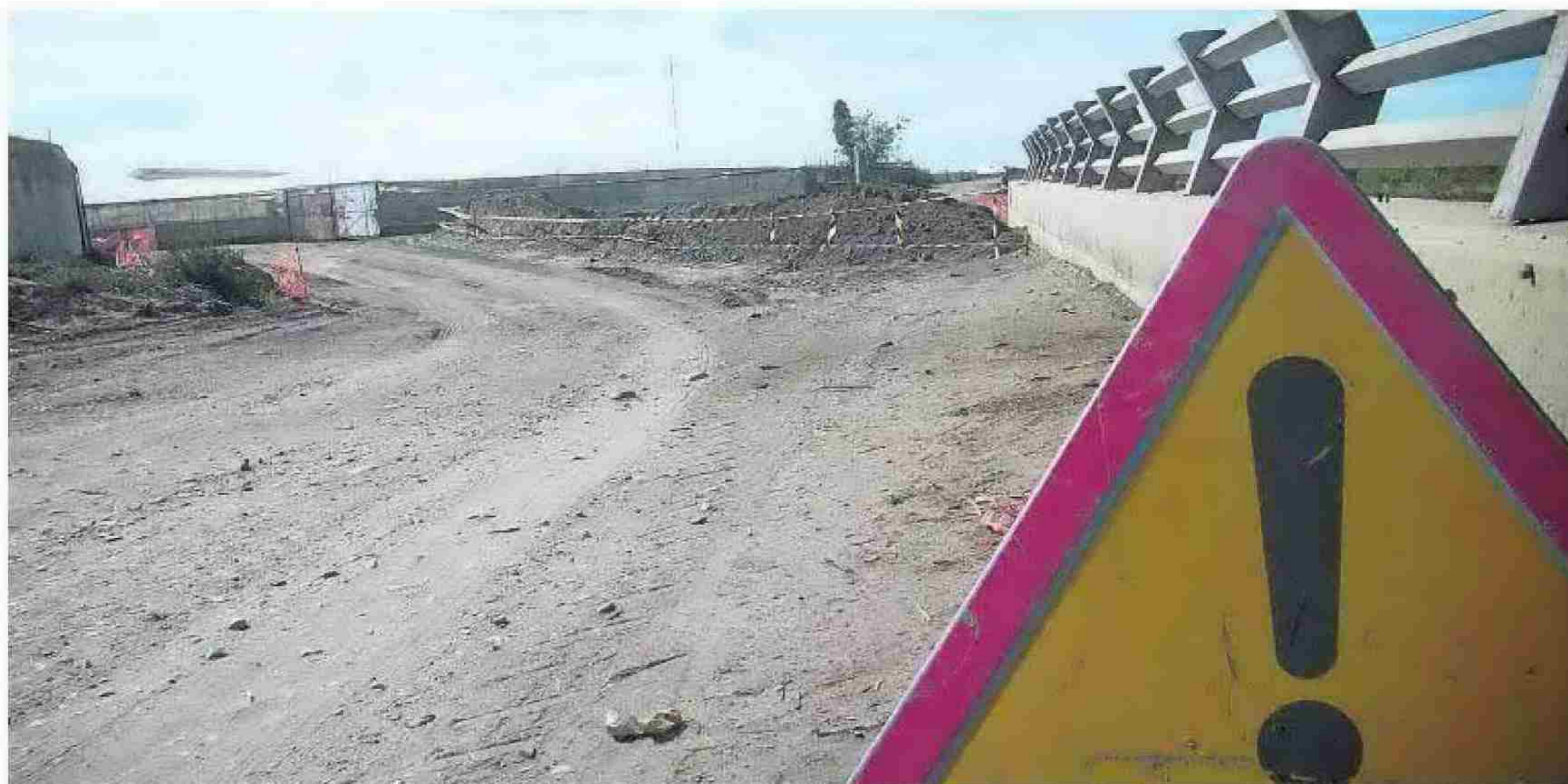
Una señal de peligro advierte de que se están llevando a cabo obras en el lugar, aunque ayer no había operarios en la zona. :: FOTOS: M. C. C. M.
