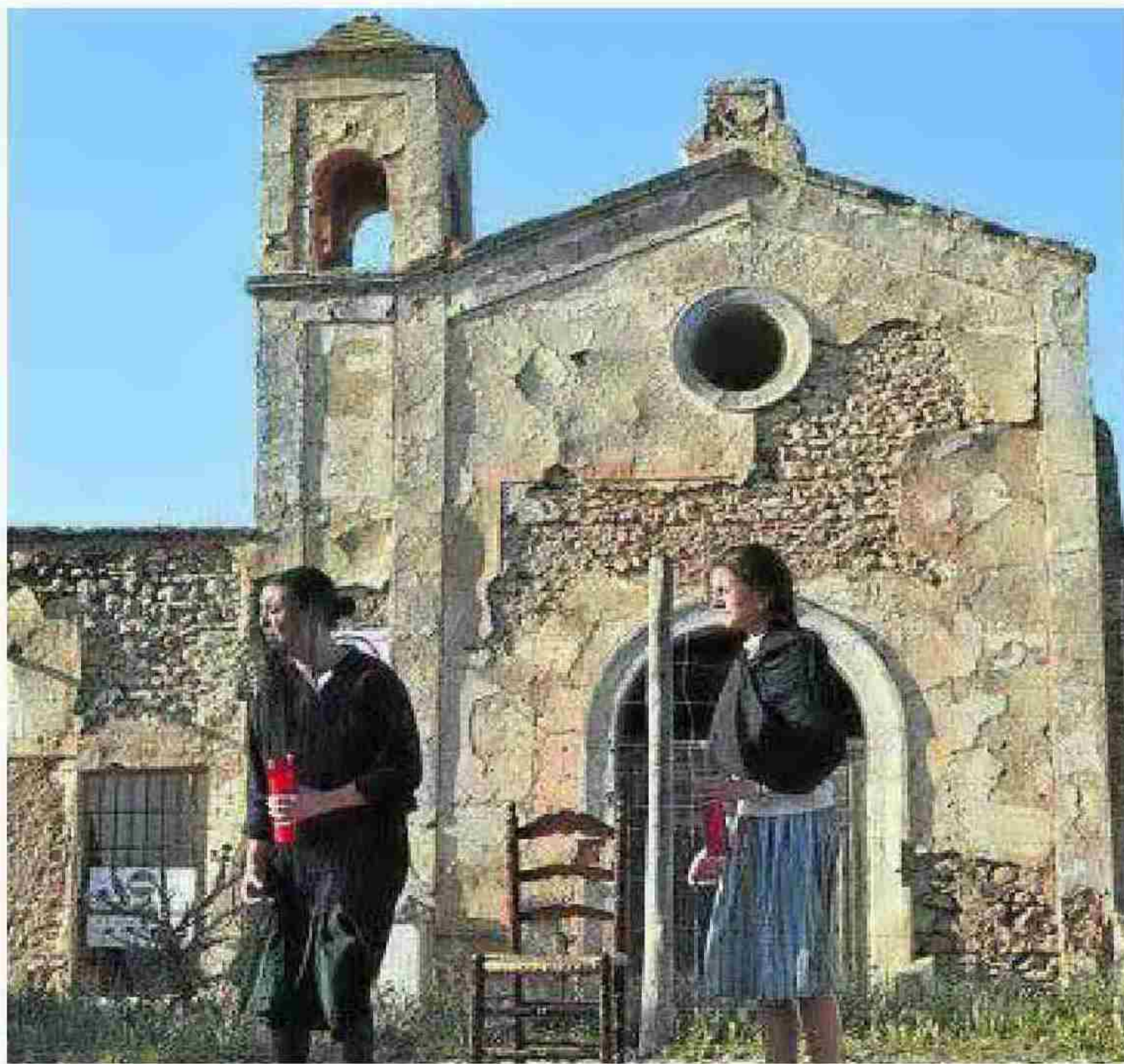
Estado actual del Cortijo del Fraile. :: IDEAL
