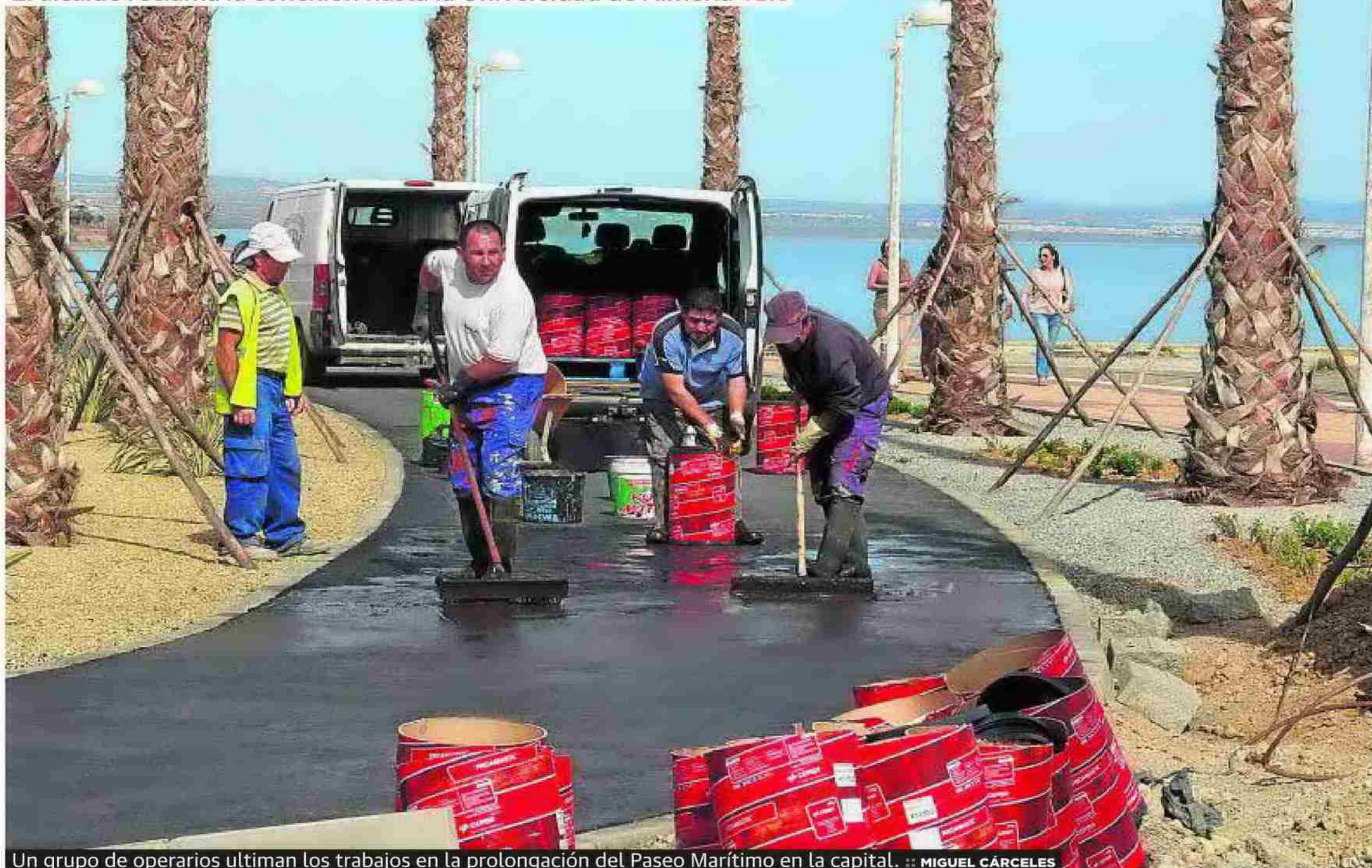
Un grupo de operarios ultiman los trabajos en la prolongación del Paseo Marítimo en la capital. :: MIGUEL CÁRCELES
