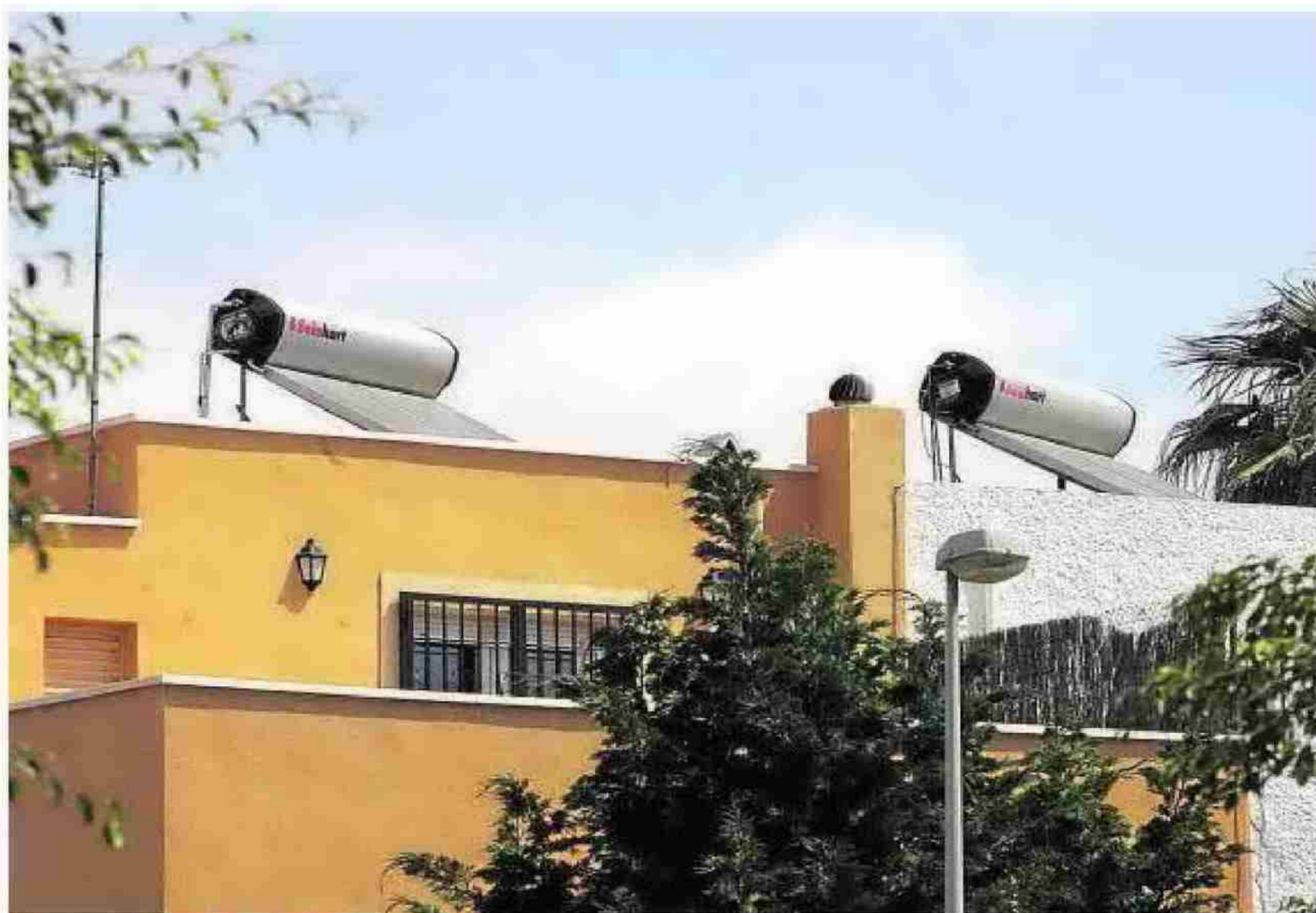
Placas solares instaladas en la azotea de una vivienda de Almería. :: IDEAL
