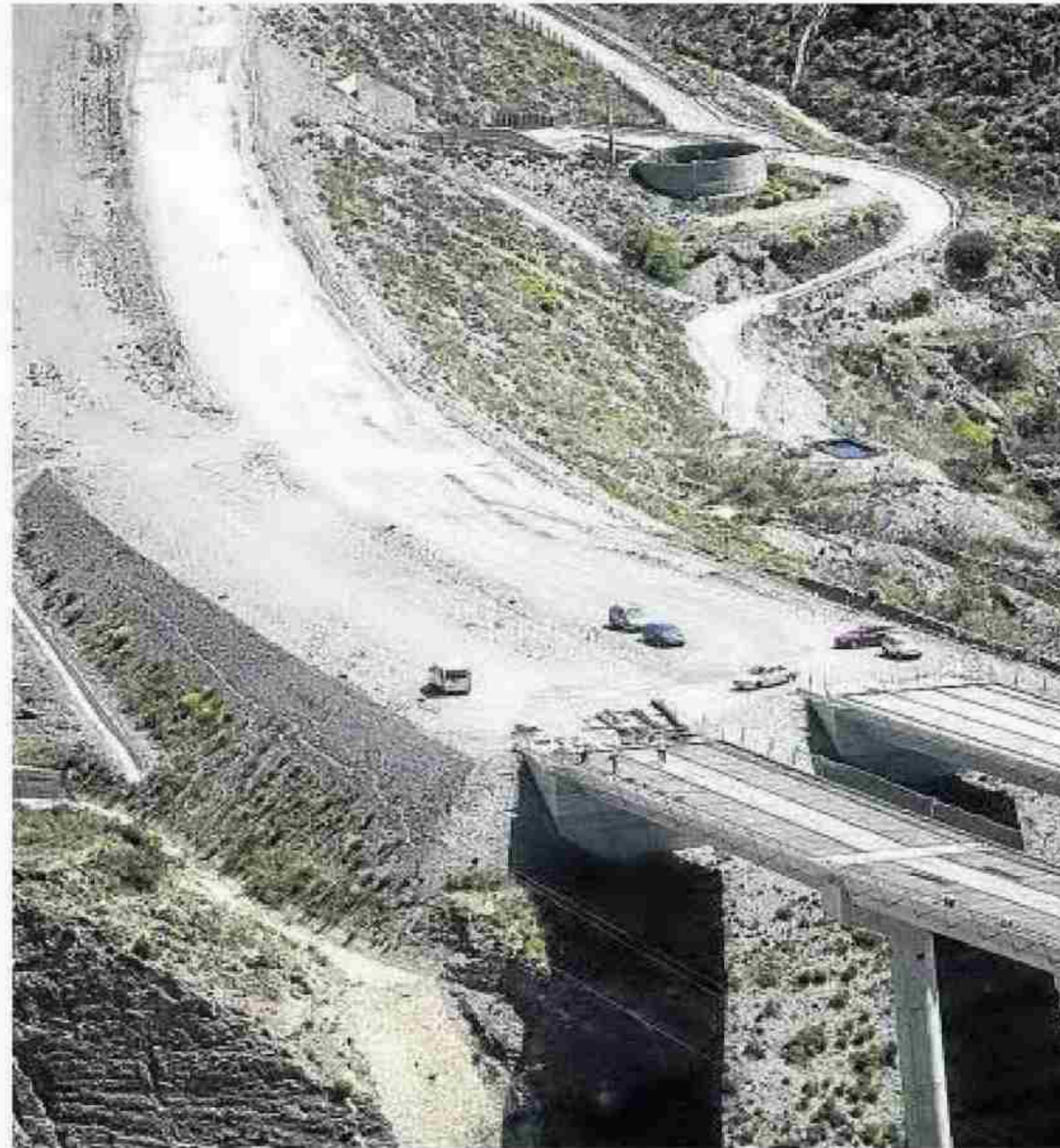
Albuñol-Polopos, uno de los tramos en obras en la A-7. :: JAVIER MARTÍN
