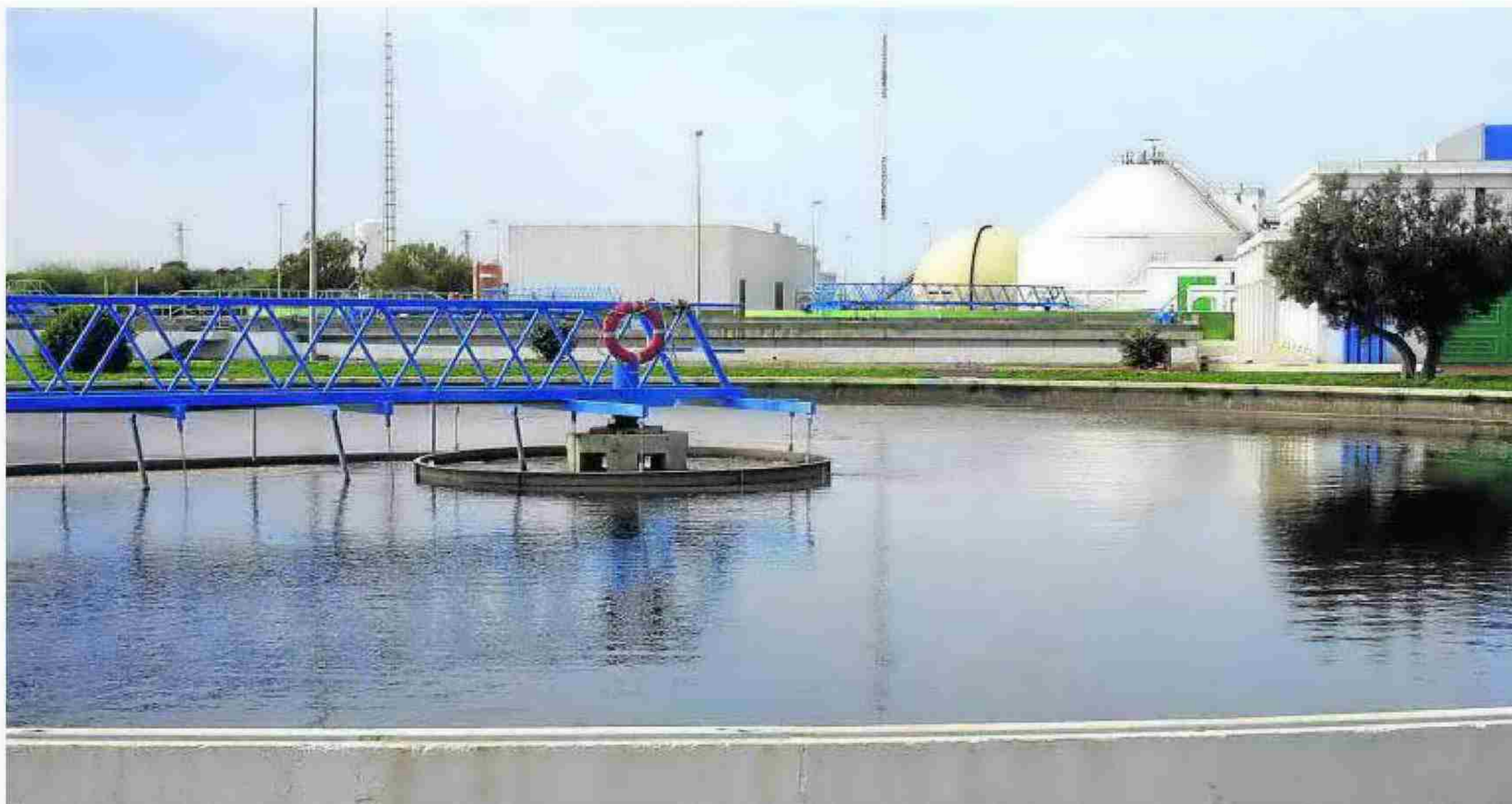
Una de las mayores depuradoras de la provincia de Almería es la de El Bobar, en la capital. :: MULLOR
