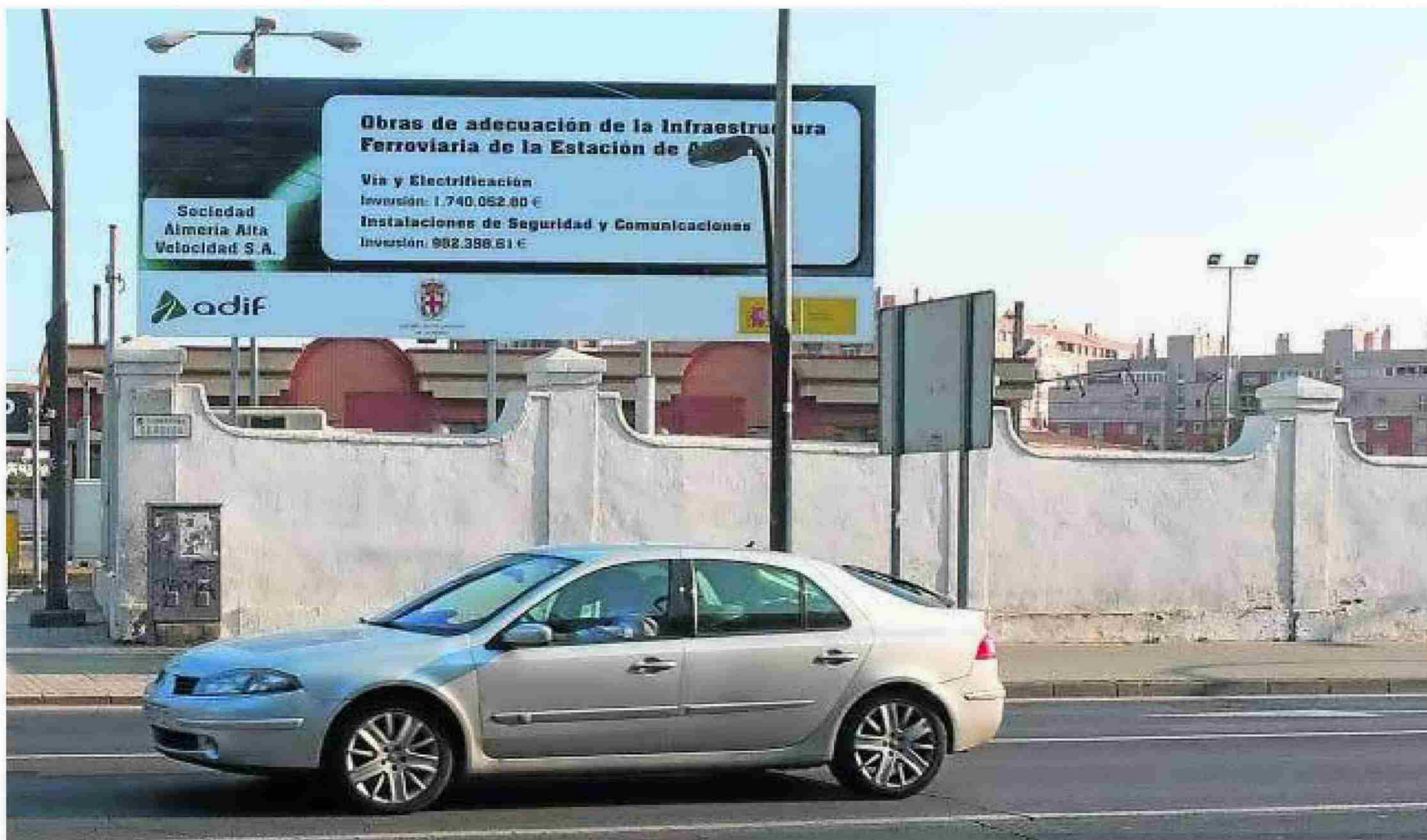
Un enorme cartel anuncia, desde ayer, el inicio de las obras de retirada de las playas de vías. :: M. C.
