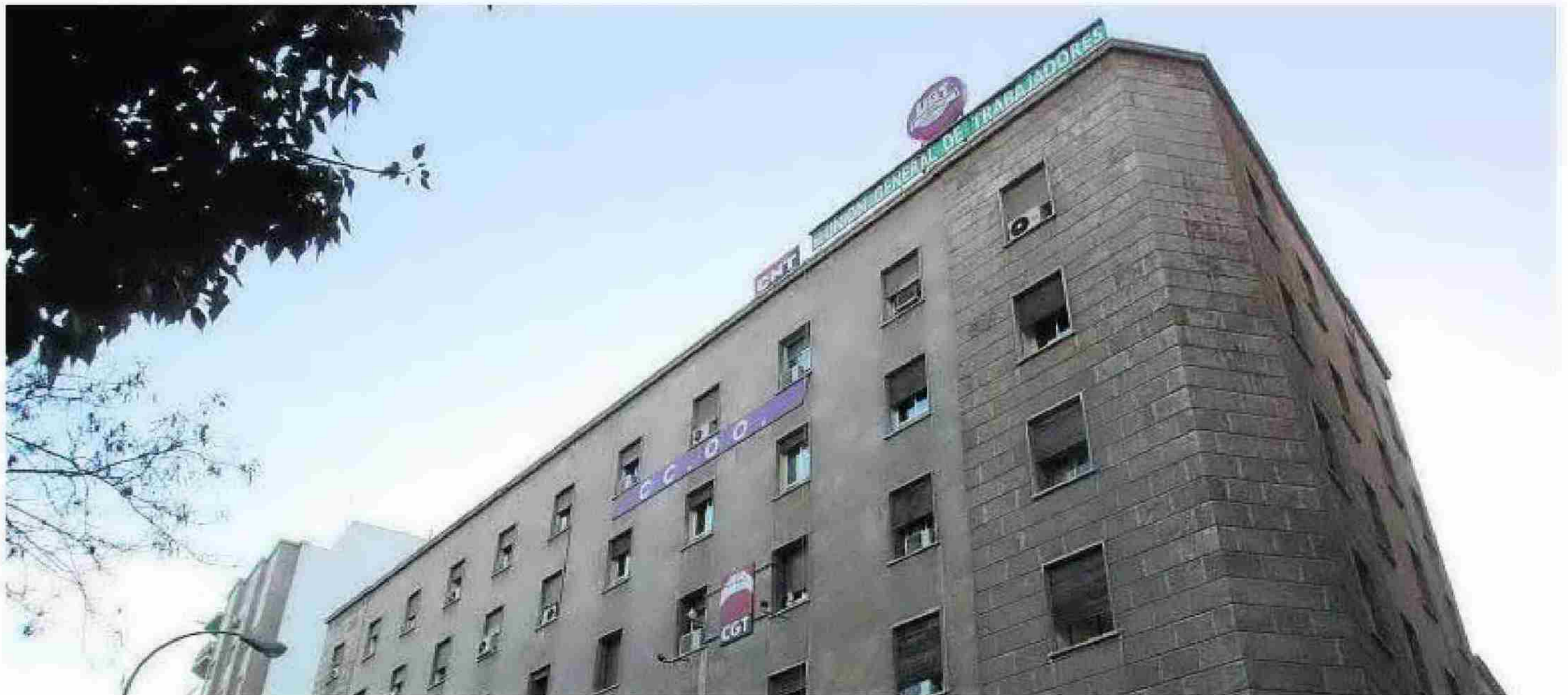
Edificio de Sindicatos, obra del arquitecto Antonio Góngora Galera. :: MANZANO
