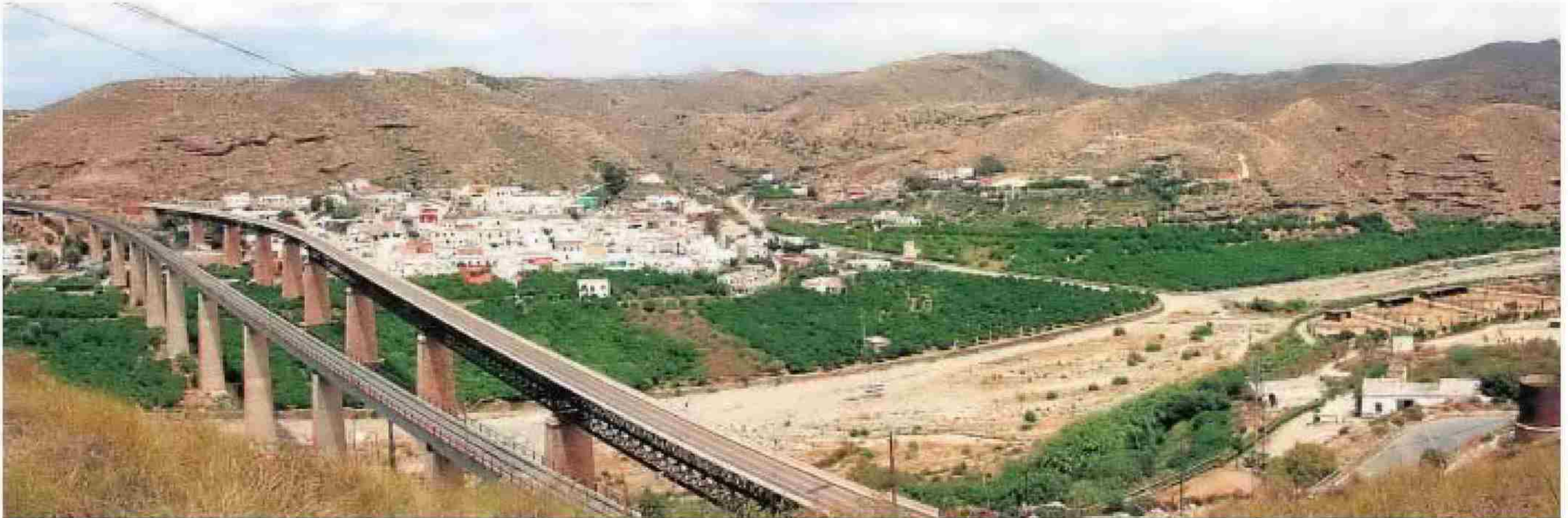
Vista panorámica del municipio de Santa Fe de Mondújar, enclavado junto al río Andarax y marcado por el imponente puente ferroviario.
