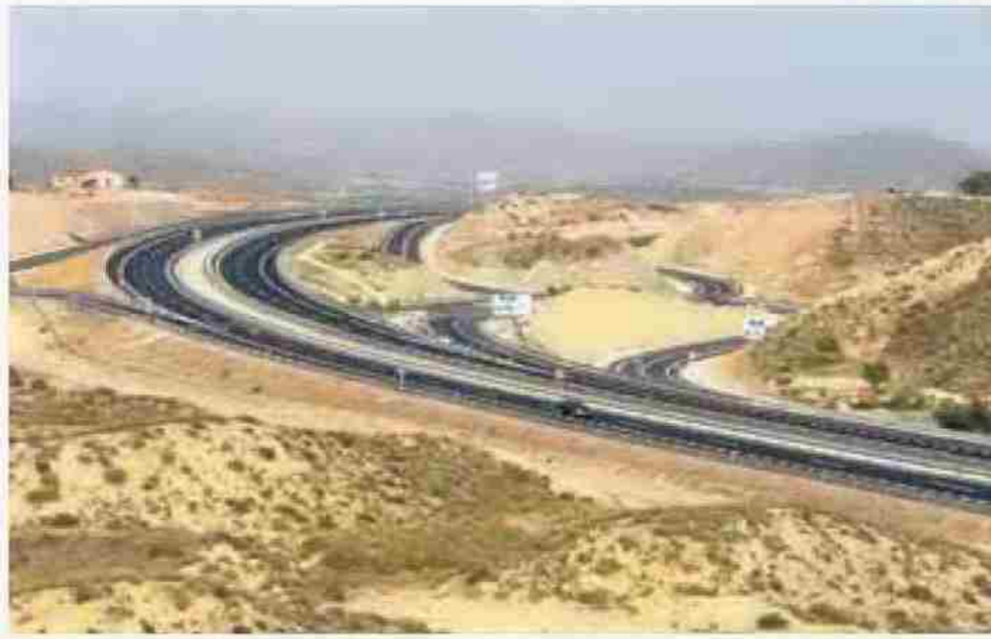
UN TRAMO abierto de la Autovía del Almanzora.
