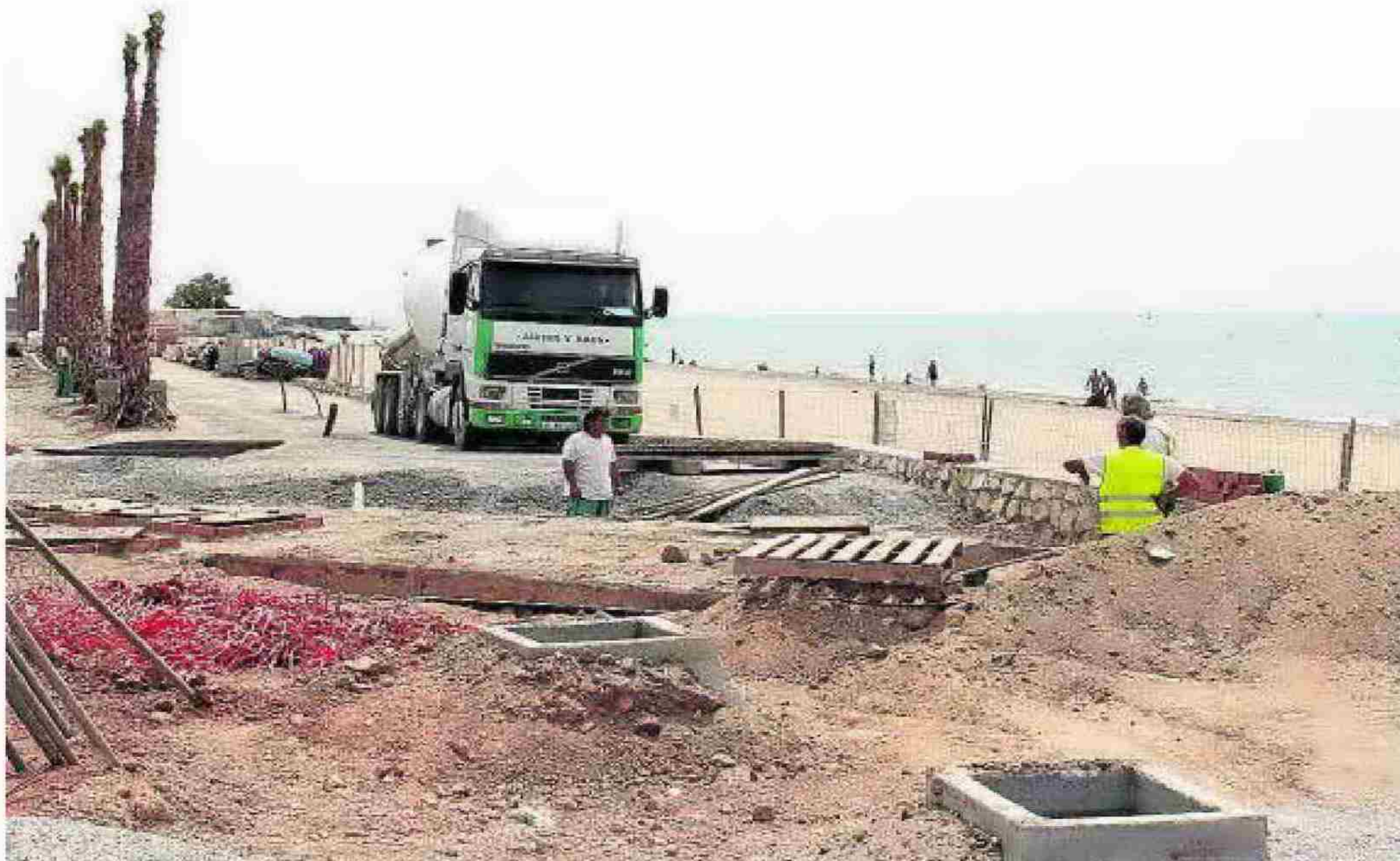
Obras de construcción del Paseo Marítimo de Almería en la Avenida del Cabo de Gata. :: c. L.
