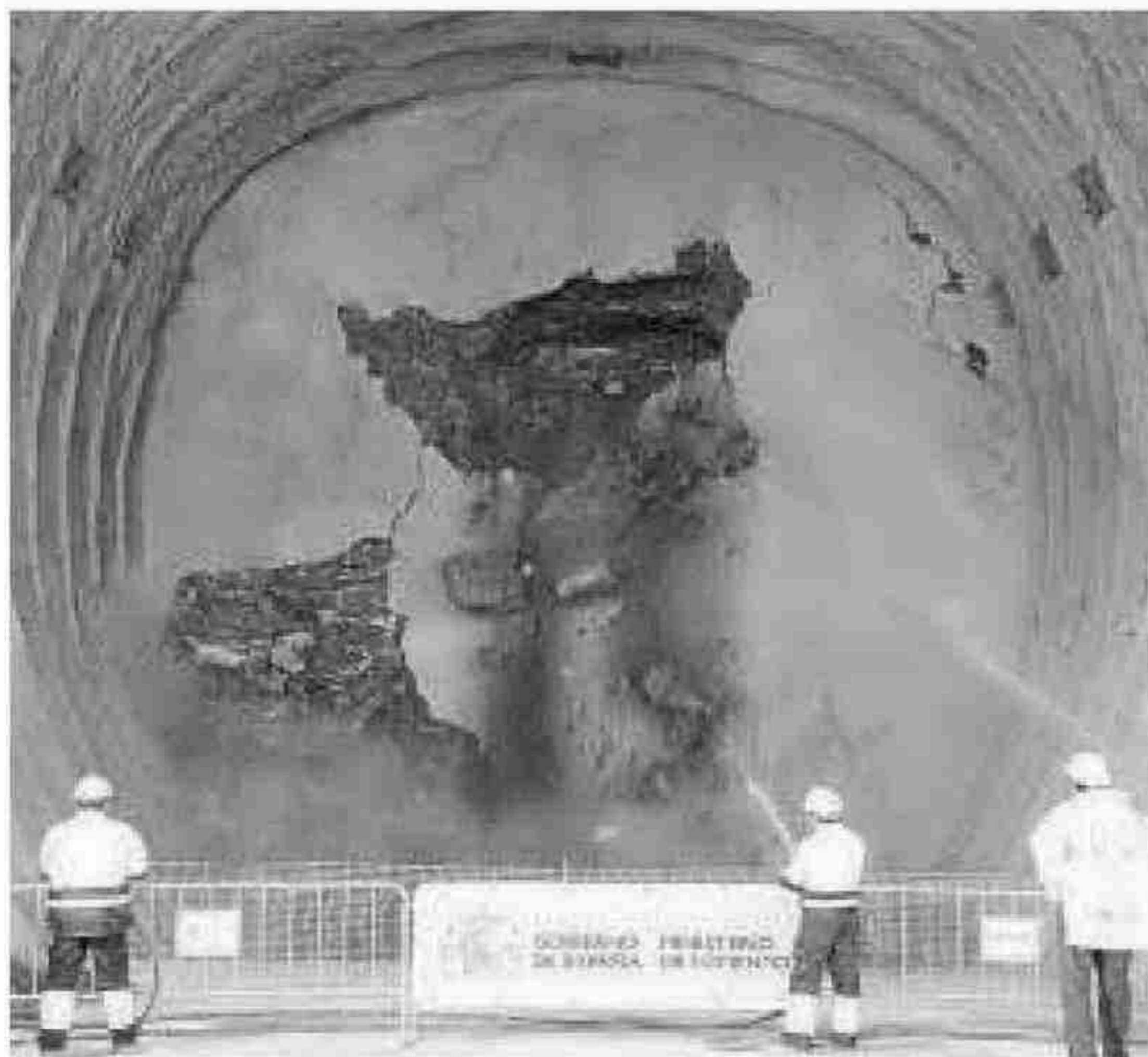
Trabajos de la tuneladora en el tramo entre Los Gallardos y Sorbas.
