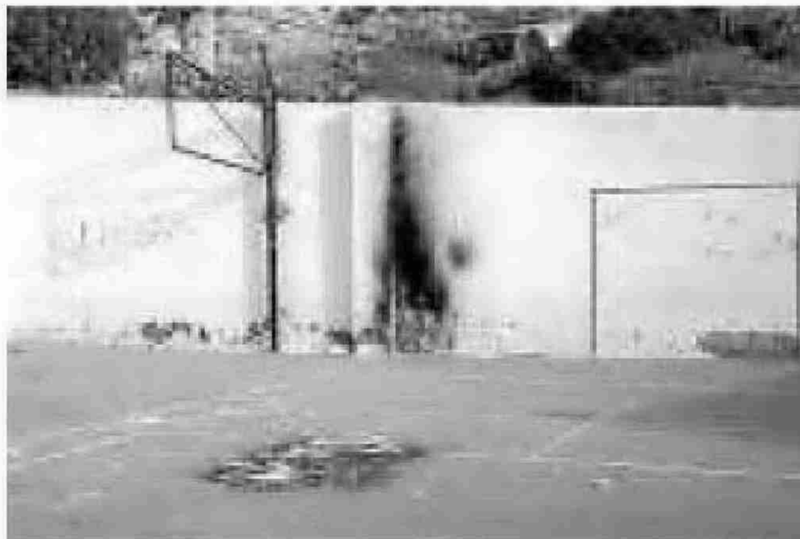
Patio del colegio donde irá ubicada la sala multiusos.
