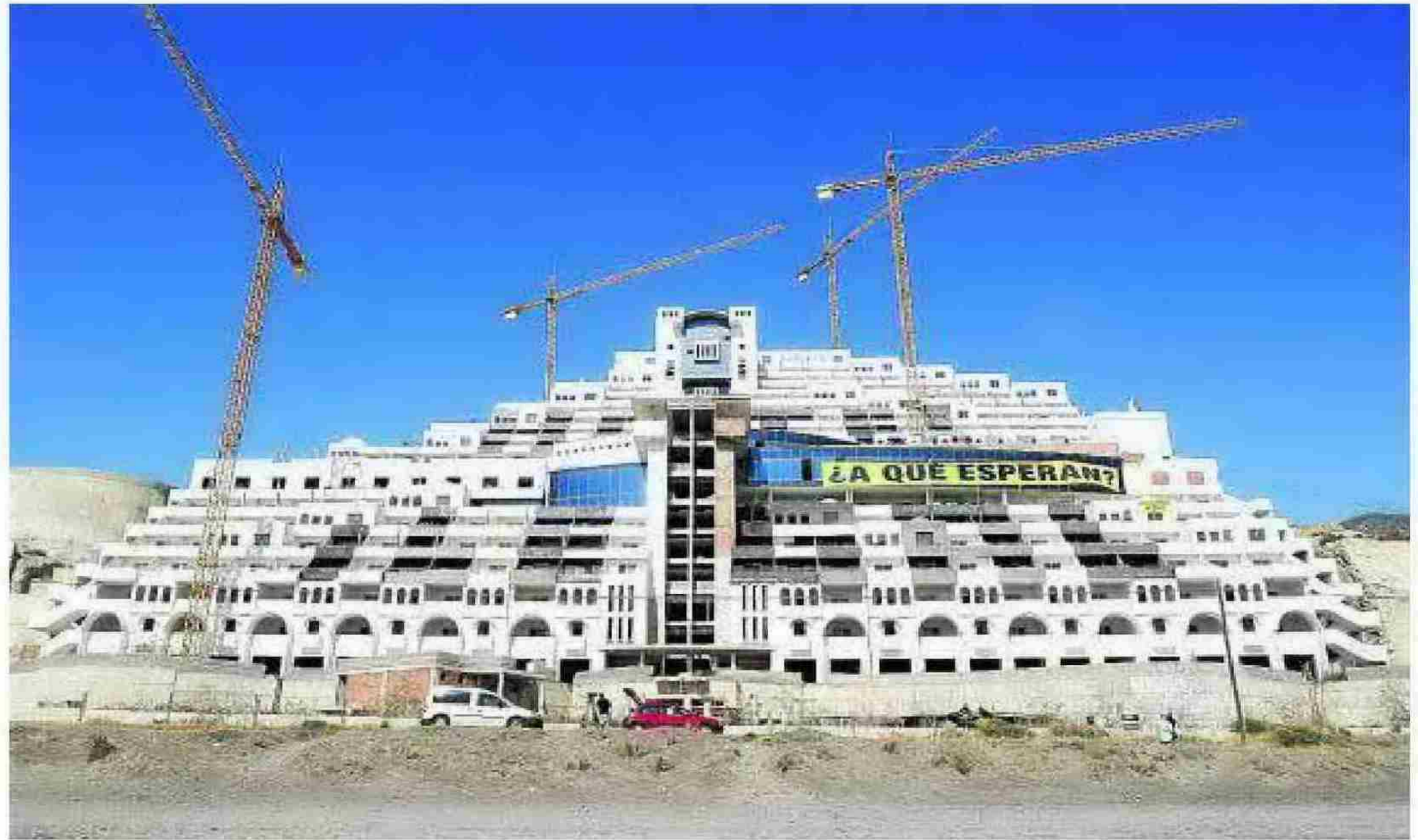
Imagen del hotel de El Algarrobico con las obras paralizadas. :: IDEAL
