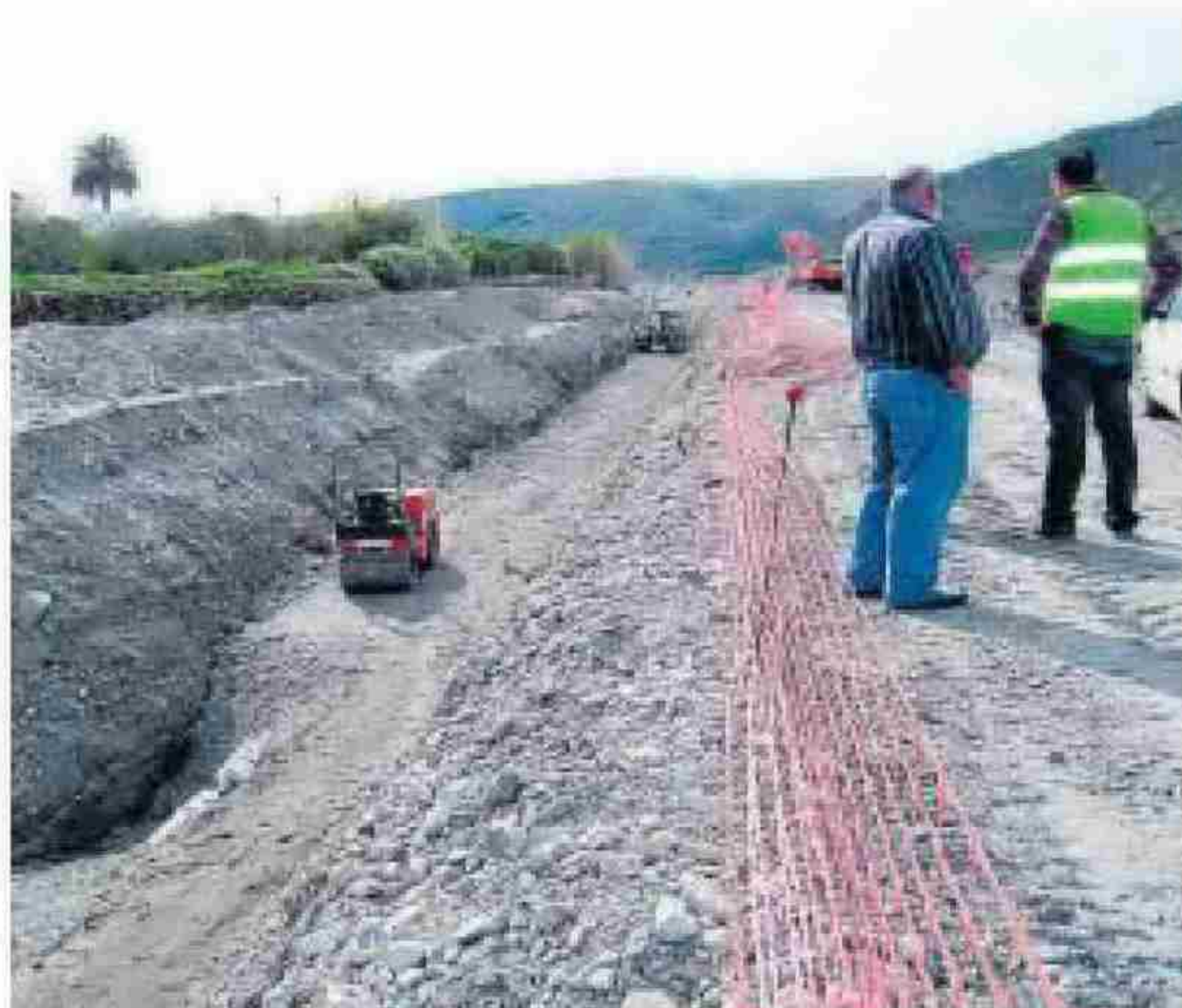
Los trabajos conllevan un gran movimiento de terrenos.
