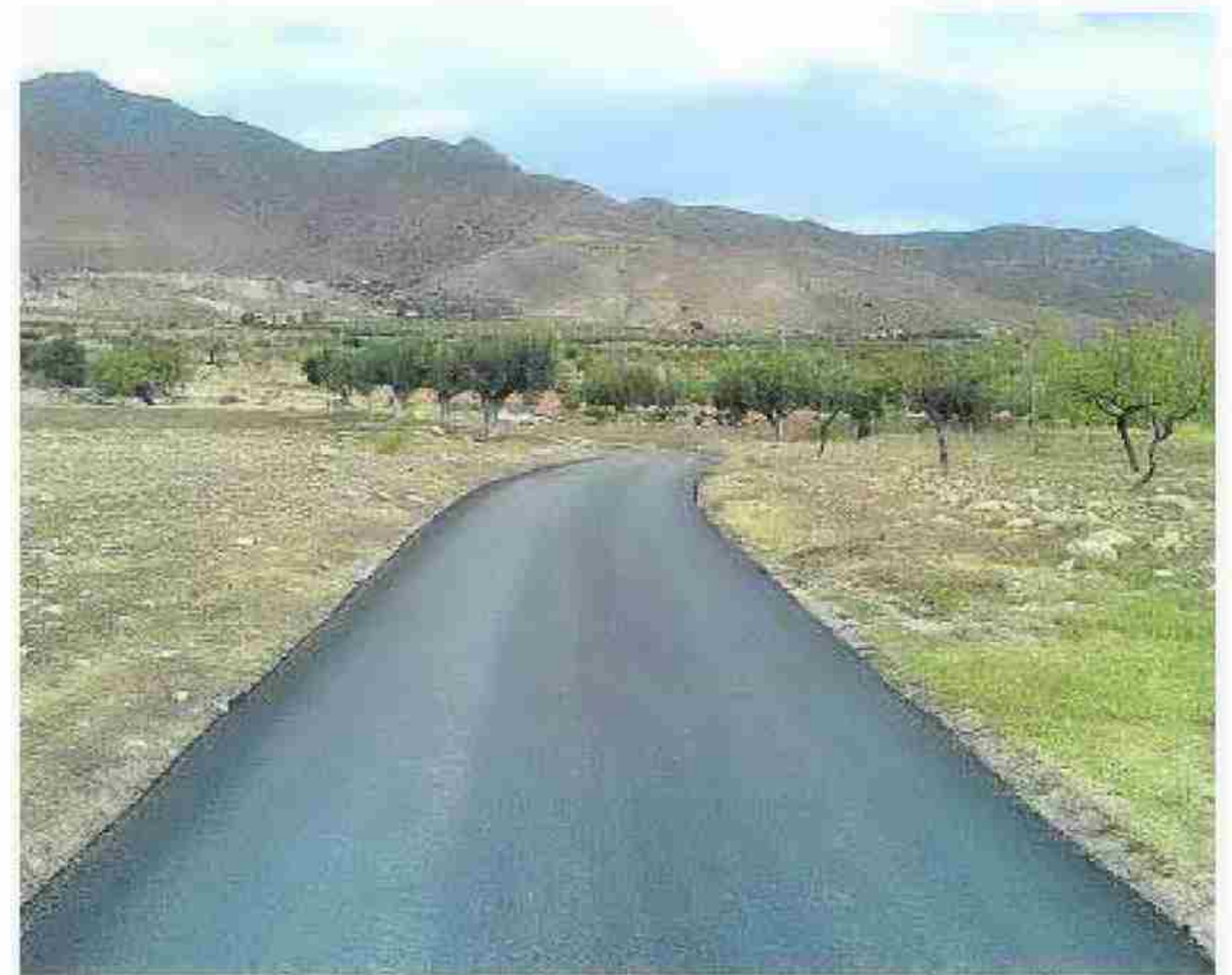
Camino recién asfaltado en Uleila del Campo. :: IDEAL
