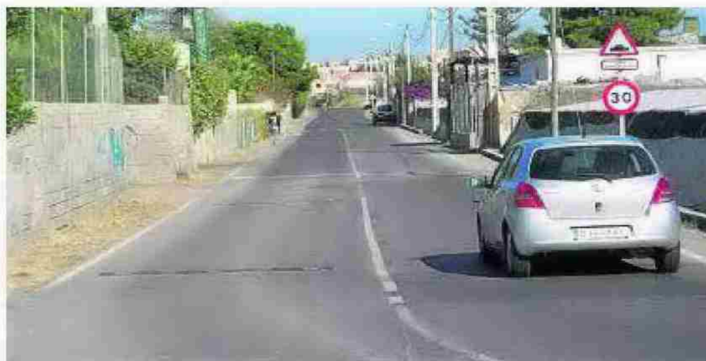
El Ayuntamiento realizará una acera en la carretera de Sacramento.
