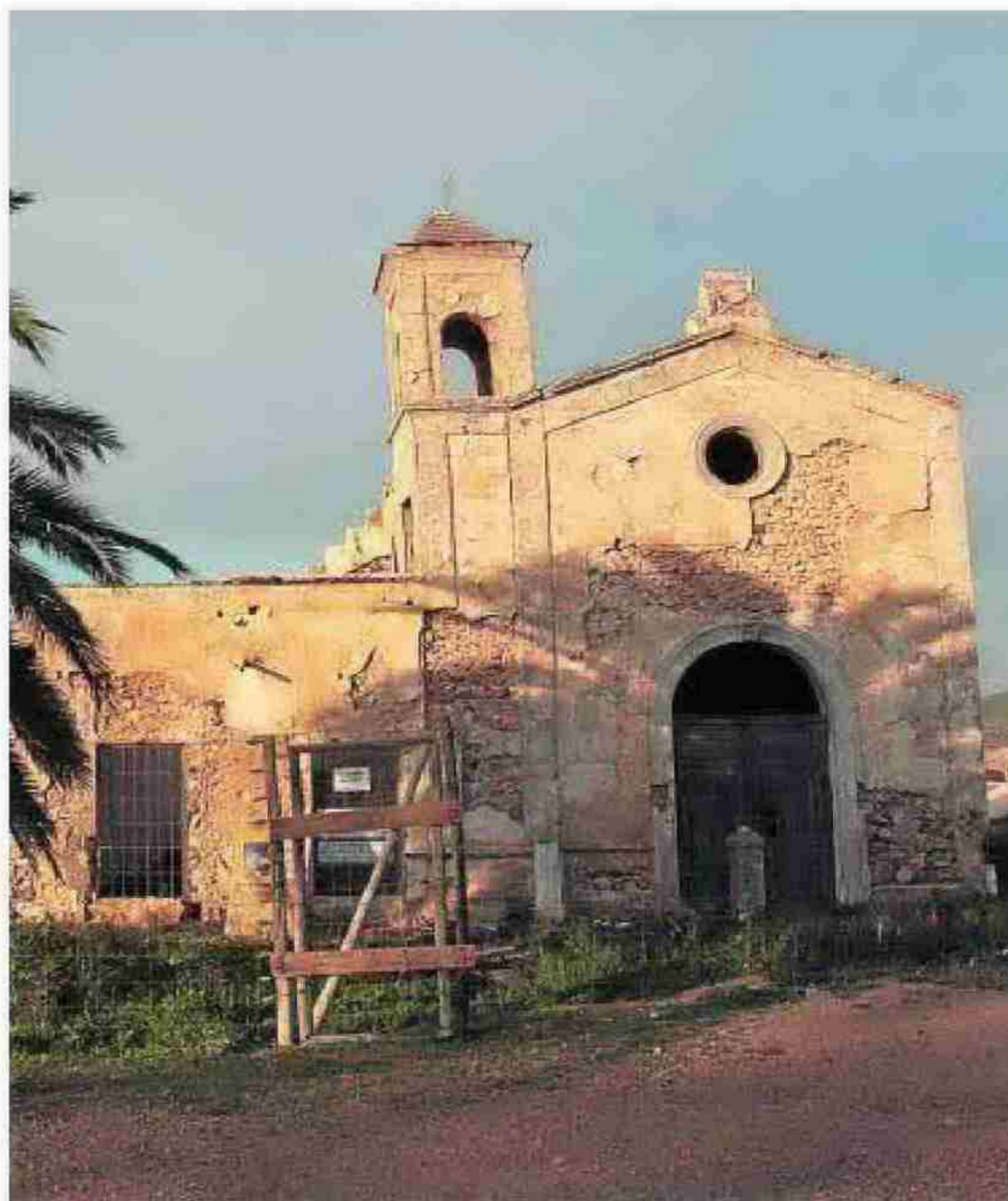
Estado actual del Cortijo del Fraile. :: IDEAL
