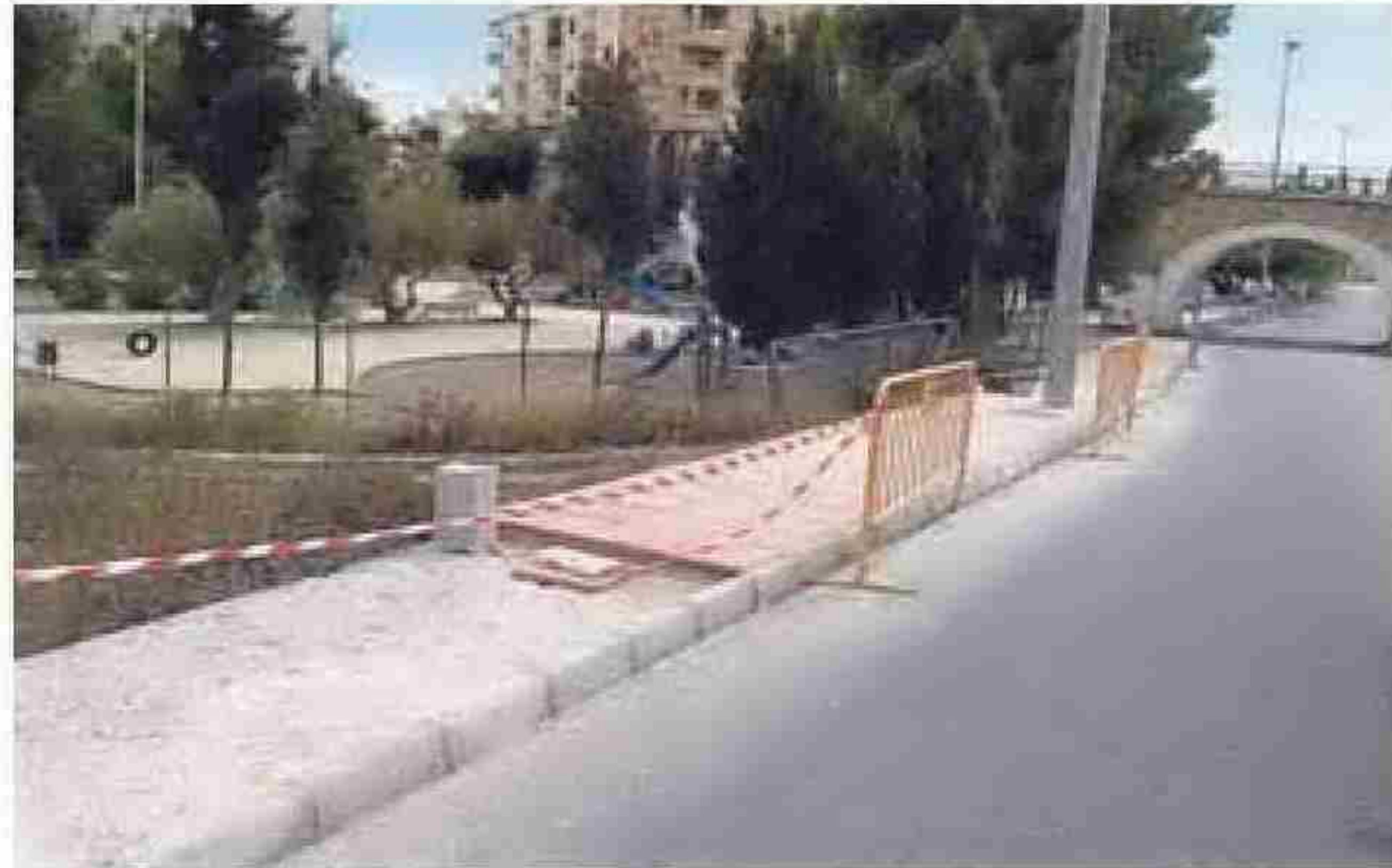
OBRAS de mejora junto a uno de los muros de la rambla.
