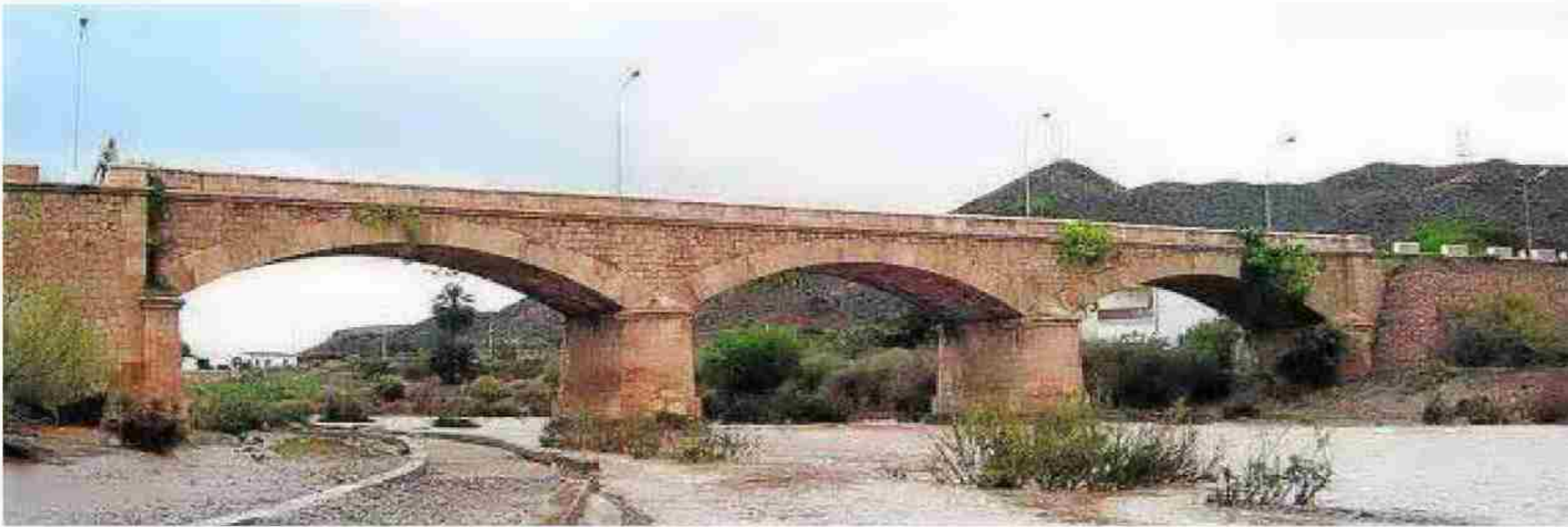
El puente de Los Lobos, antes de caer, debajo, lo que quedó del sendero por la rambla, al mes de hacerlo.
