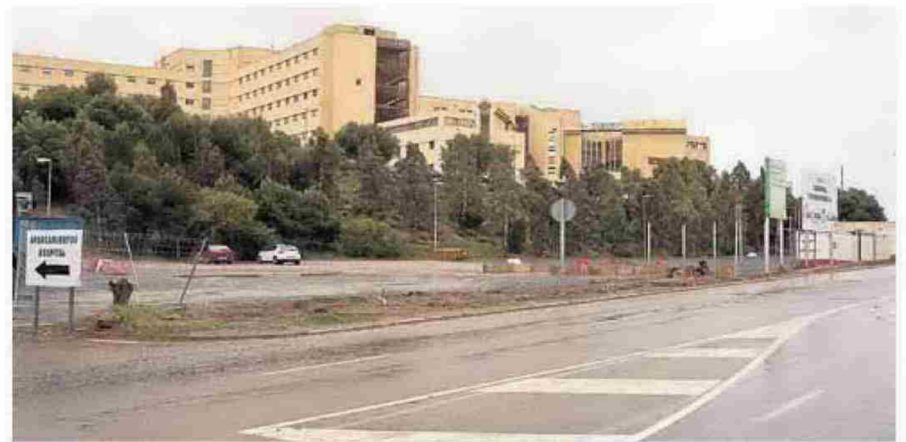
SOLAR en el que se levantará el hospital Materno Infantil de Almería. LA VOZ
