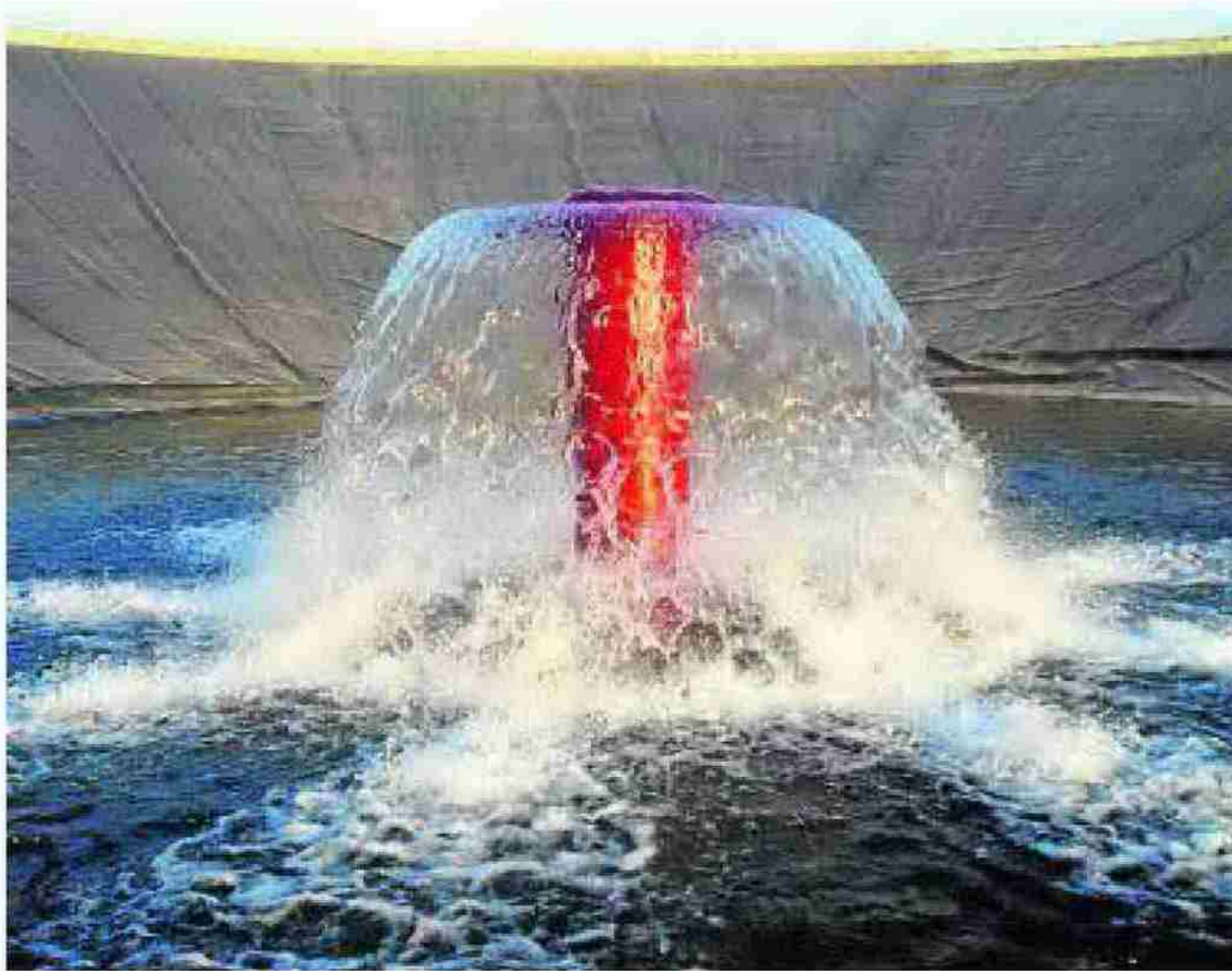
Entrada de agua a la desaladora de Carboneras. :: IDEAL
